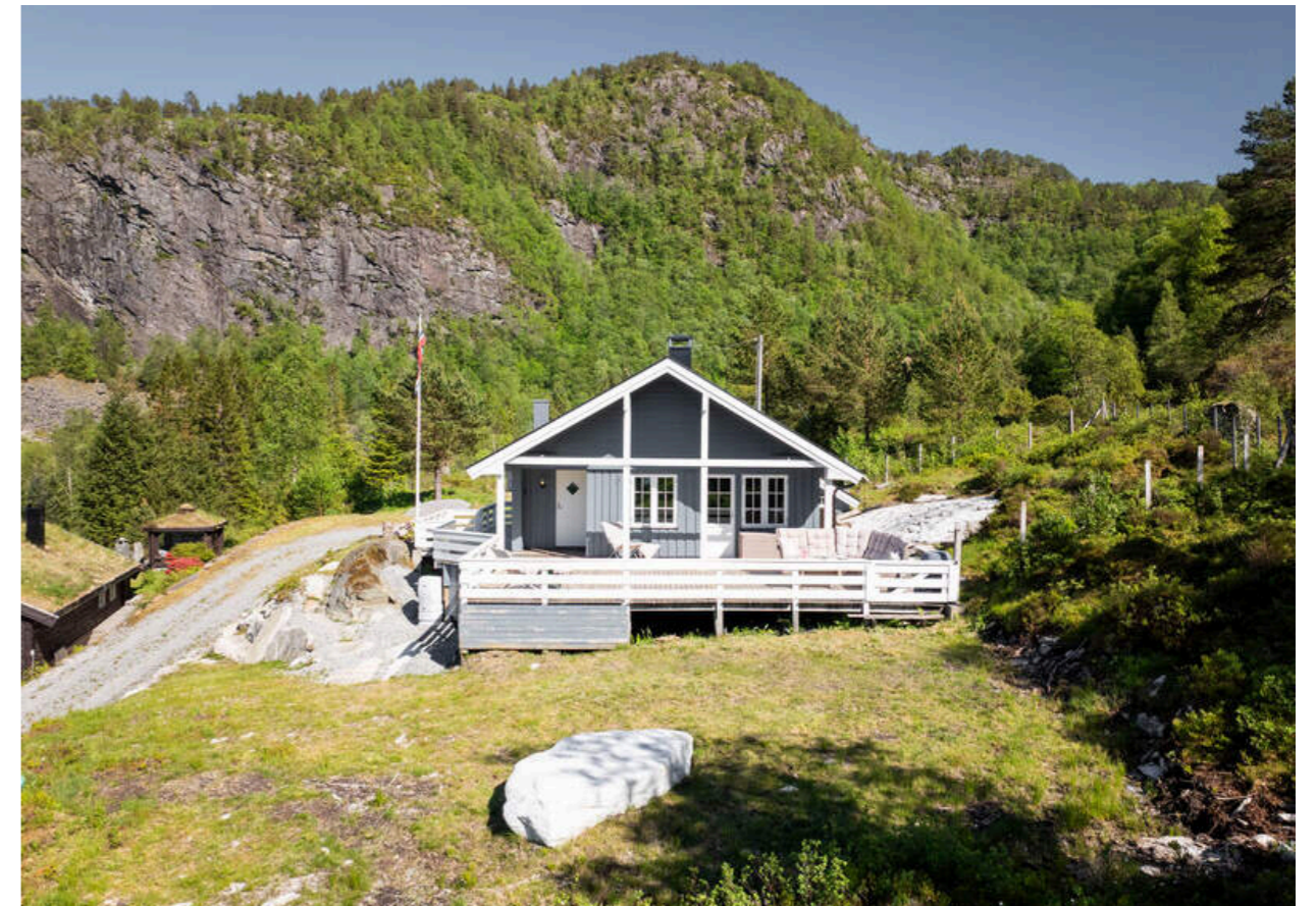
- Hytten er godt vedlikeholdt i selgers eiertid. Det er lagt nytt tak, vindskibord, forbore, takrenner og pipehatt i 2021 -
