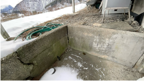
Mangler rekkverk eller annen form for sikring.
