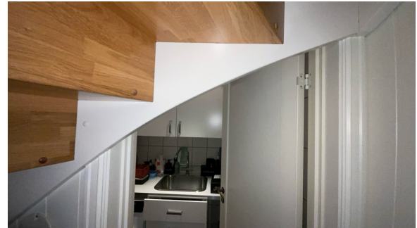
Trappevange opptar deler av døråpning til vaskerommet.
