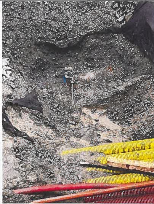
Bilde 2: Masser av pukk, sand og grus 0 - ca. 2 m dybde. Foto: Gaute Helland.
