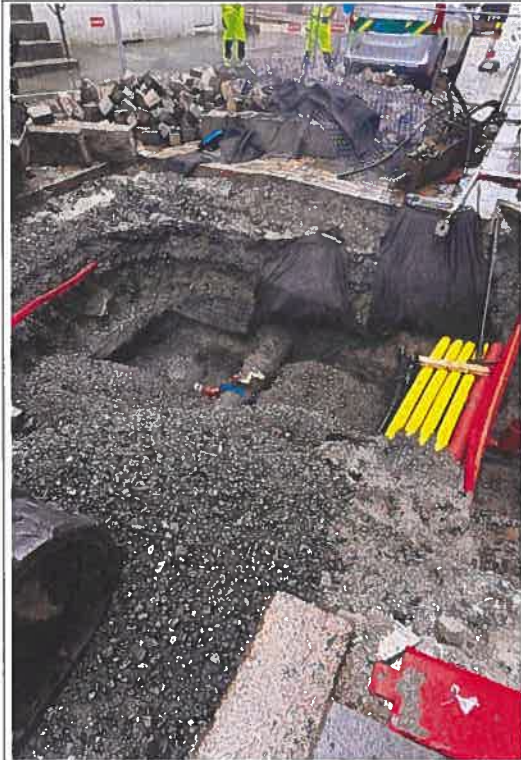
Bilde 3: Masser av pukk, sand og grus 0 – ca. 2 m dybde. Foto: Gaute Helland.
