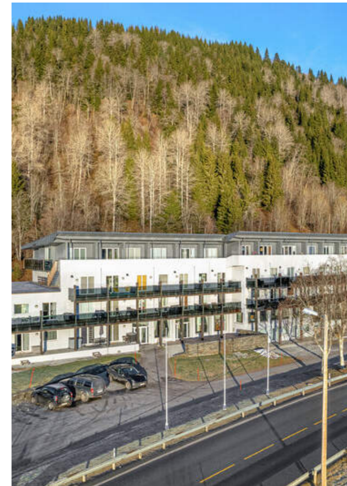
På sameiets grunn er det parkeringsplass med El-bil lading.
