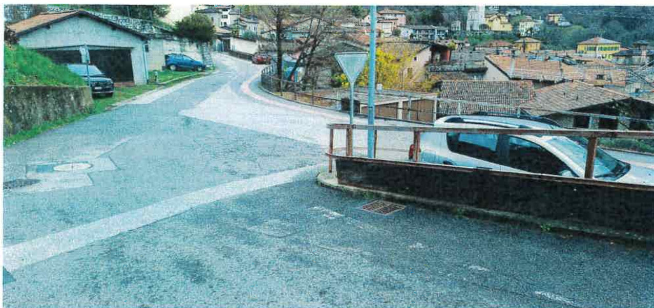
Figura 5 Segnaletica a terra praticamente scomparsa e segnaletica verticale completamente scolorita all'imbocco di Stráda da Vissín da Stráda da Pügèrna
