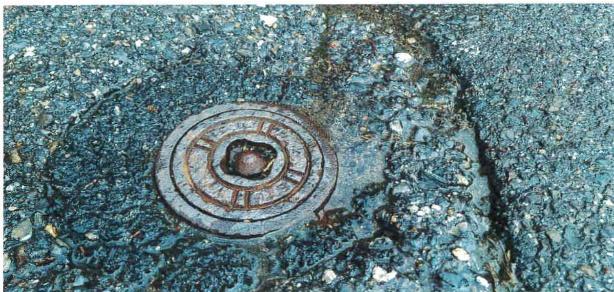
Figura 4 Dettaglio saracinesca con acqua in uscita sul lato destro su Stráda da Vissín
