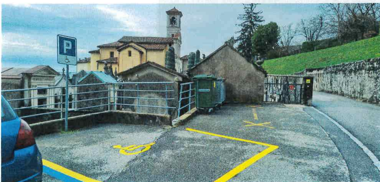
Figura 11 Muro di sostegno dei posteggi dietro al cimitero con evidente segno di spostamento del manufatto
