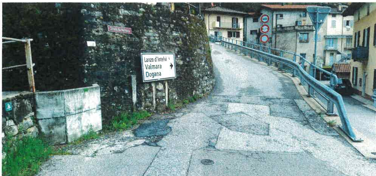
Figura 11 Angusto imbocco di Stráda da Valmára molto dissestato e ceduto all'altezza del manufatto in beton sulla sinistra
