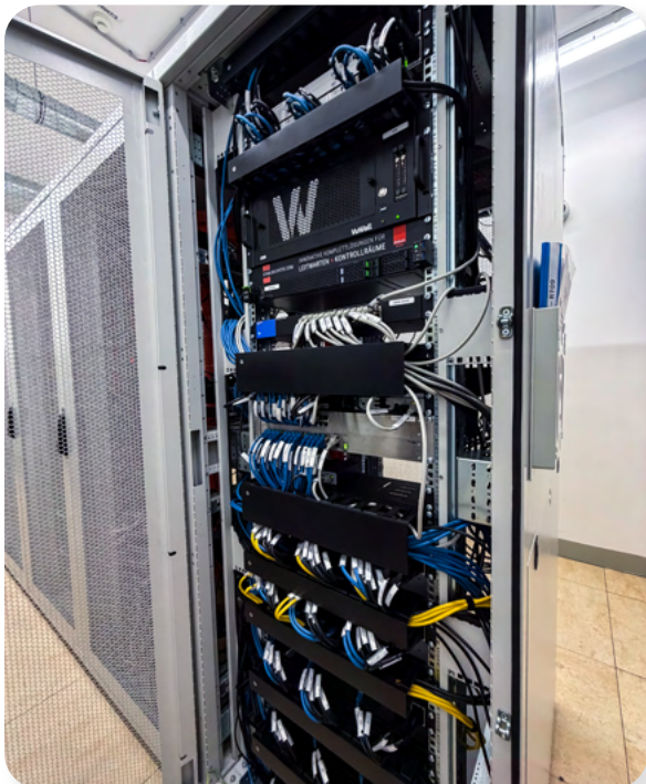
Serverrack mit VuWall Videowandcontroller
