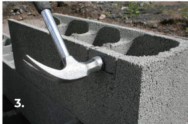
Kuva 3. Kuvasarja 1-4 kuvat: Päätyharkon sahaus kulmissa
