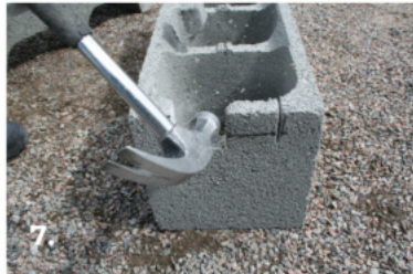
Kuva 4. Kuvasarja 5-8 kuvat: Päätyharkon sahaus suorassa seinässä
