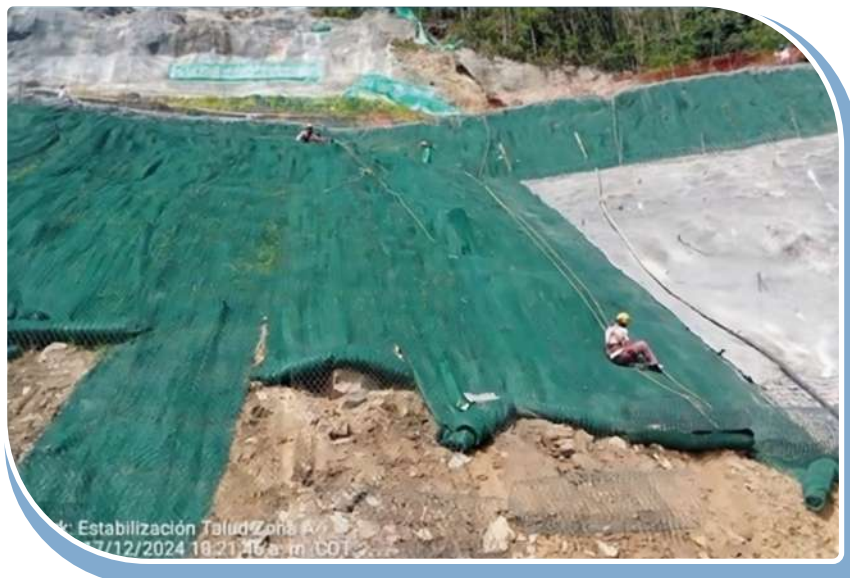
Estabilización del talud K0+900
