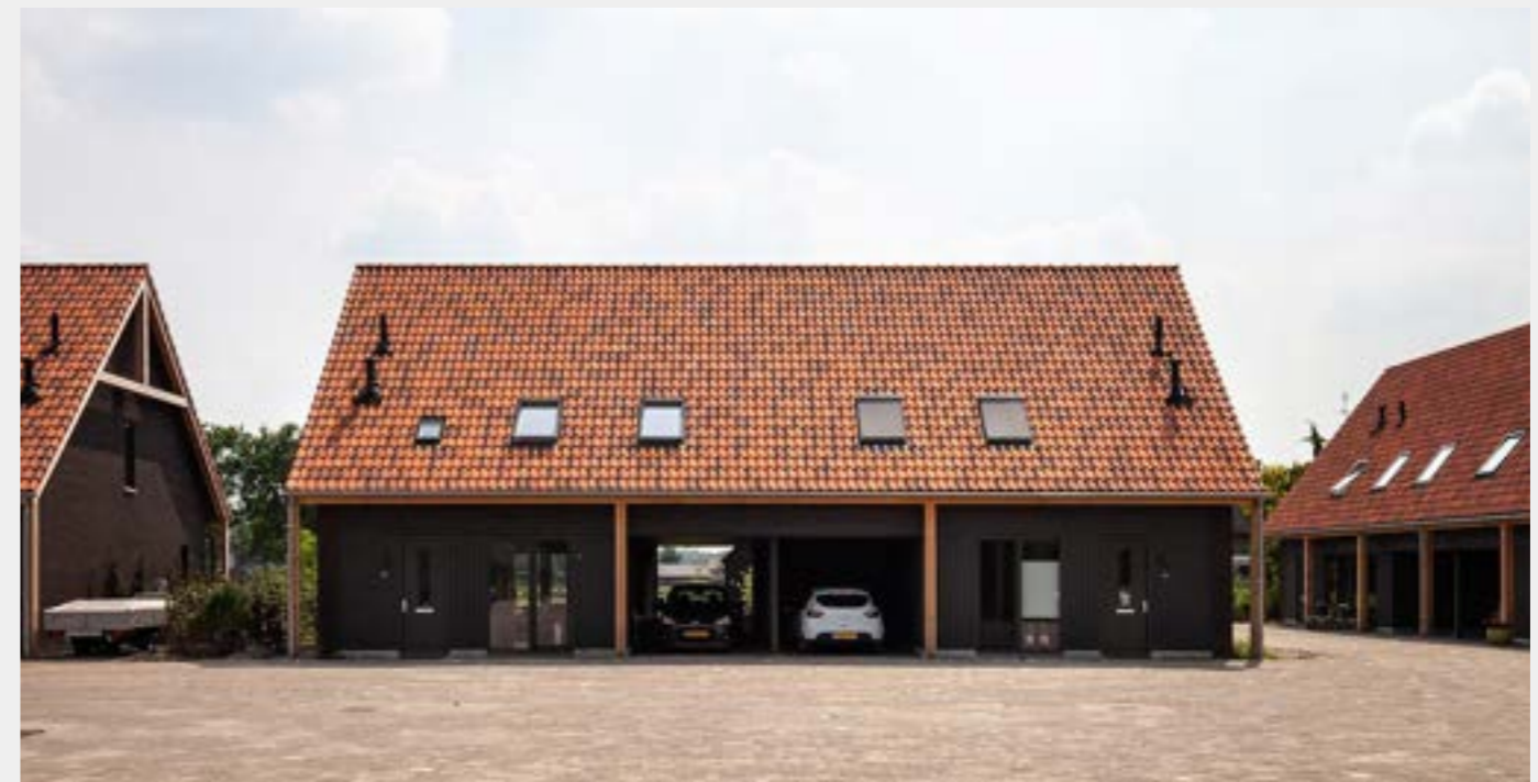
Geen rode dakpannen
