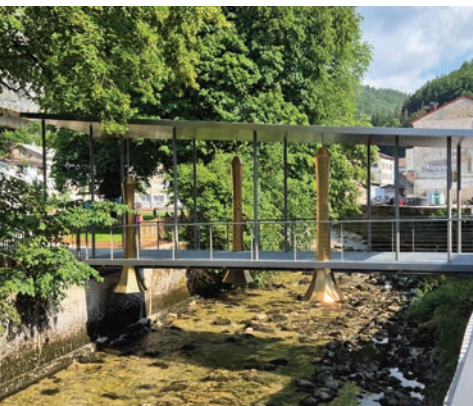
Passerelle du Jardin Lamy Jeune Hauts de Bienne, France. 2025
