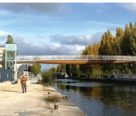
Passerelle sur le Canal de l'Ourcq Bondy, France. 2025
