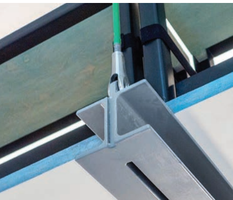
Réhabilitation de l'Ecole des Mines Paris, France. 2023
