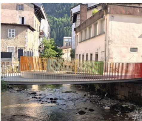
Passerelle du Quai Lamy Hauts de Bienne, France. 2025
