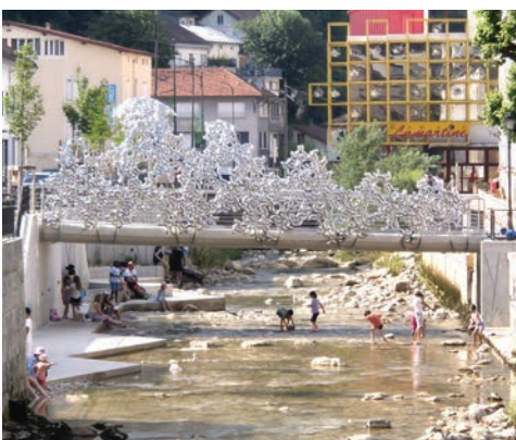
Passerelle du Quai Jobez Hauts de Bienne, France. 2025
