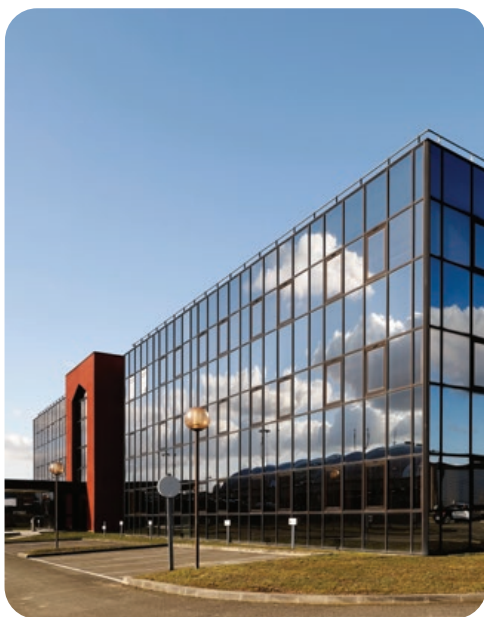
Le bâtiment Elium, au M Veillage d'Élancourt (78) Parc de l'Envol
