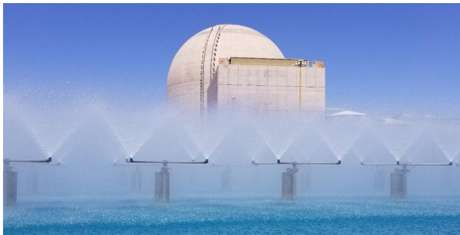
Figur 6-5: Et kjølebasseng med vanddyser ved kjernekraftverket Palo Verde. Kilde: U.S NRC [43].
