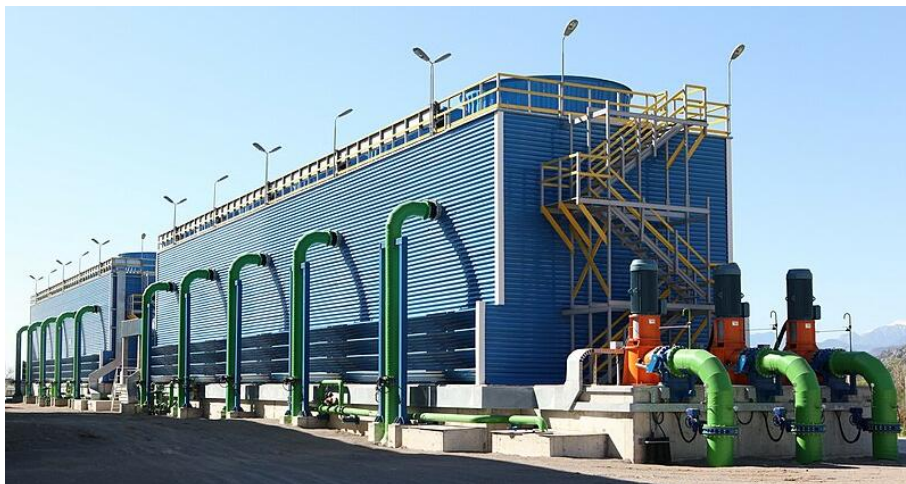
Figur 6-4: Et moderne kjøletårn med som bruker både vifter og kjølevann. Foto: Cenk Endustri (Wikimedia Commons).
