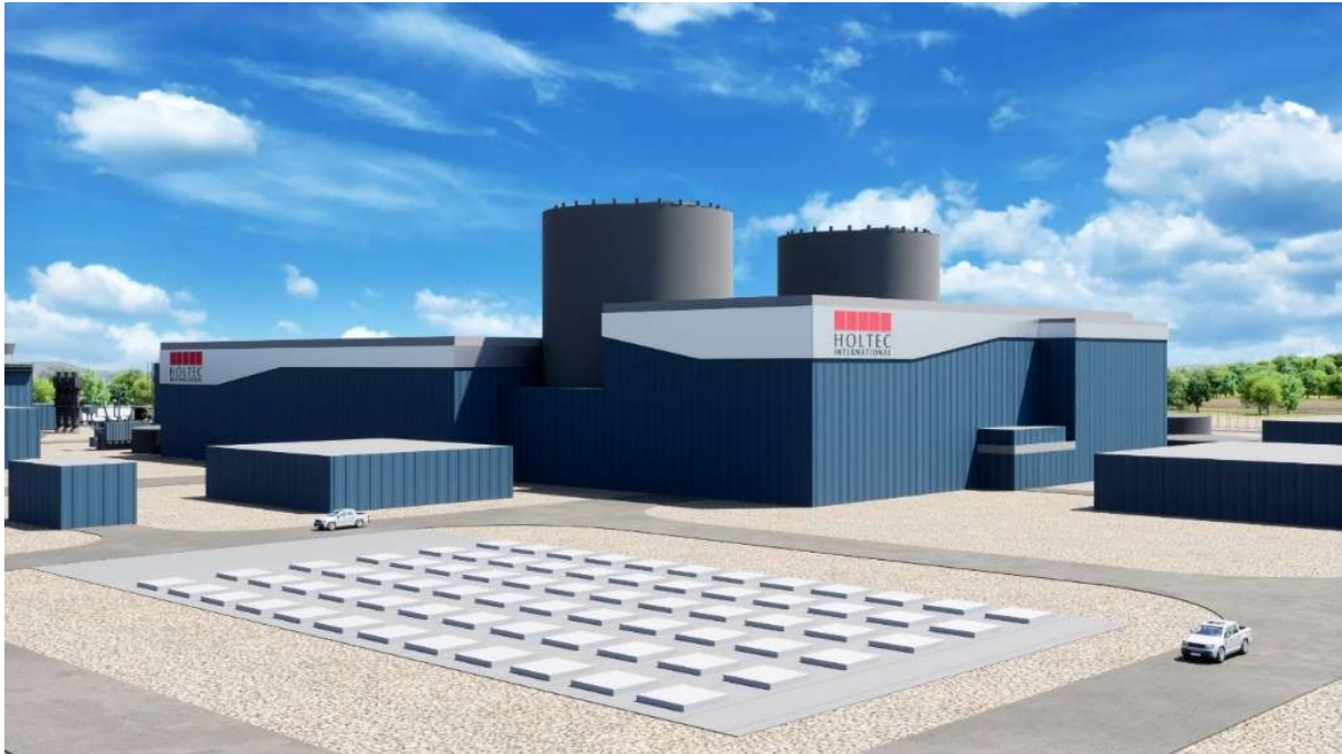
Figur 3-3: Holtec SMR-300. I forgrunnen ses et mellomlager for brukt brensel. Kilde: Holtec.
