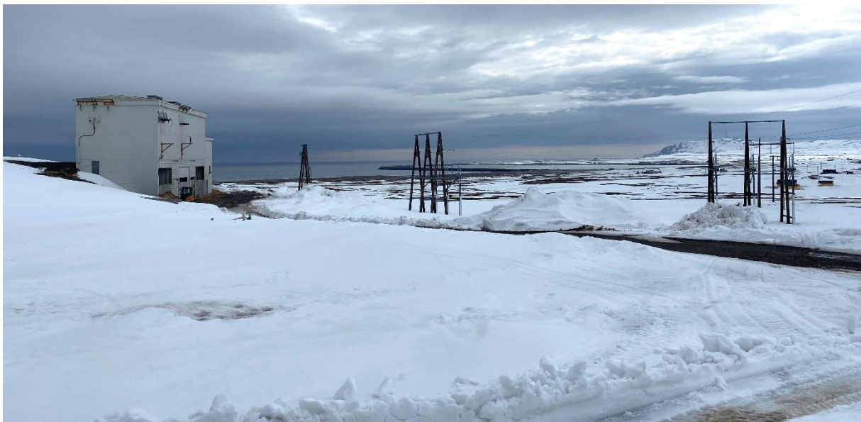
Figur 14: Tiltaksområdet sett fra nord mot sør. Den nå stengte trafoen ses til venstre i bildet.
