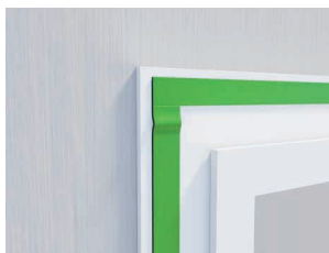
Respecter une surlongueur de 1 cm par jonction
