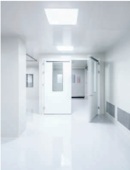
Demontierbare Schleuse zur Anlageneinbringung
