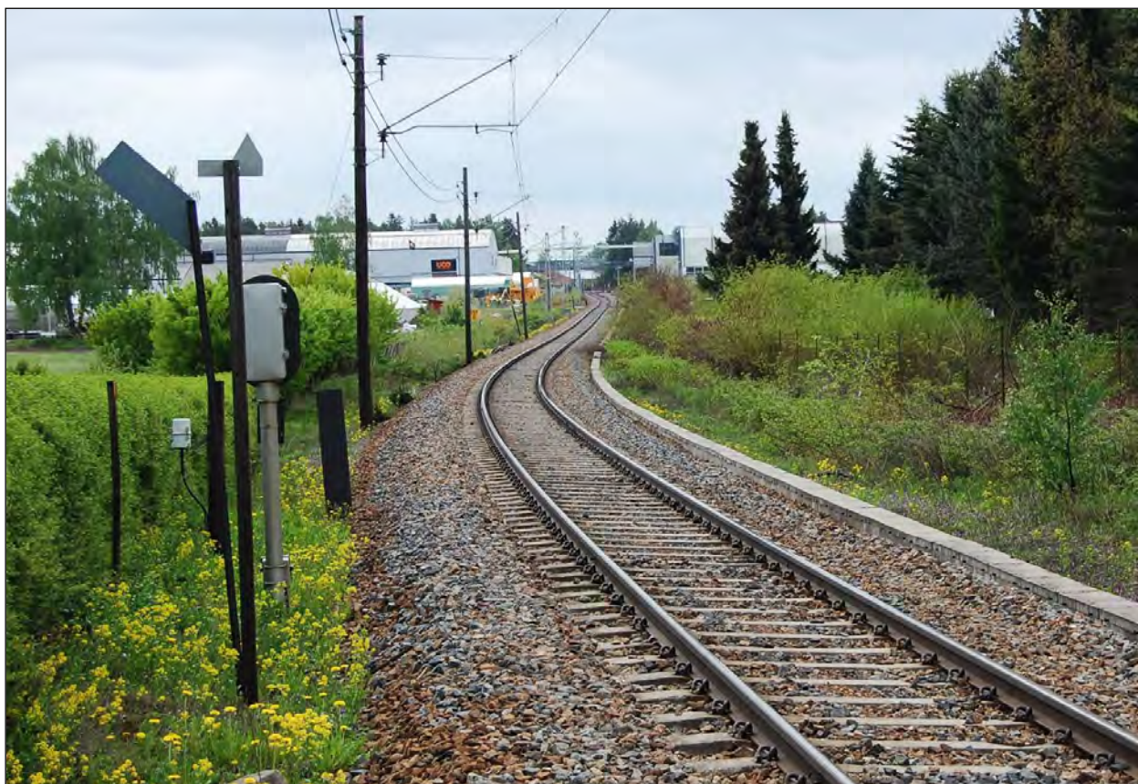
Bilde 17: Nord for de to største produksjonshallene til Moelv Industrier ligger de anbefalte banene vest for eksisterende trasé (til høyre på bildet). Den planlagte tunnelen for tog mot Gjøvik stasjon begynner ved grantrærne i høyre bildekant og går rett under stedet der bildet ble tatt. Foto: © Norsk Bane AS.
