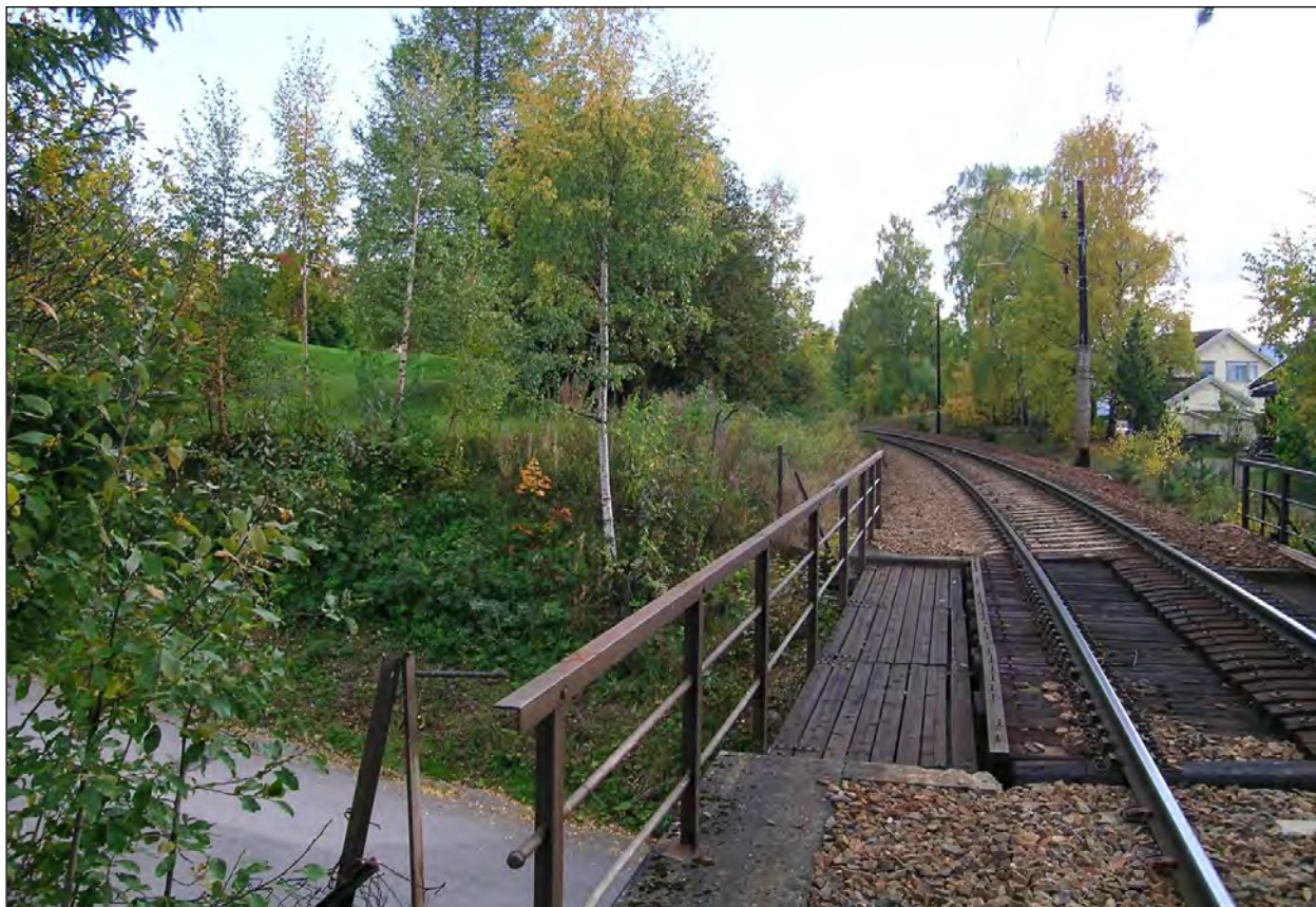
Bilde 31: Her ved Suttestad er høyhastighetsbanen planlagt lenger øst (lenger til venstre) enn nåværende spor. For beboere i Årettavegen 1, 3, 5 og 7 vil dette være lite ønskelig. Den nye banen vil imidlertid ligge en dypere skjæring enn eksisterende, noe som vil forsterke effekten av de planlagte støyskjermveggene. Foto: © Norsk Bane AS.
