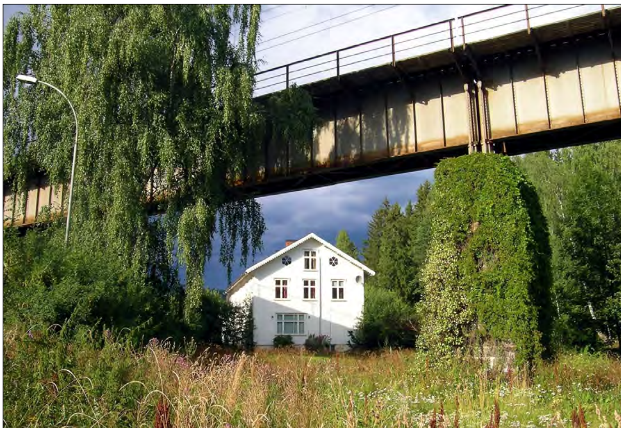
Bilde 16: Like sør for Moelv stasjon (km 104,2) går anbefalt trasé på ei bru med tre spor over bygningen i bakgrunnen, 12 meter over bakkenivå. Det kan tilsi å flytte bygningen. I tillegg vil eksisterende bru (i framgrunnen) bli erstattet av ei ny bru på omtrent samme sted, med ett spor. Se neste kapittel for forklaring. Foto: © Norsk Bane AS.
