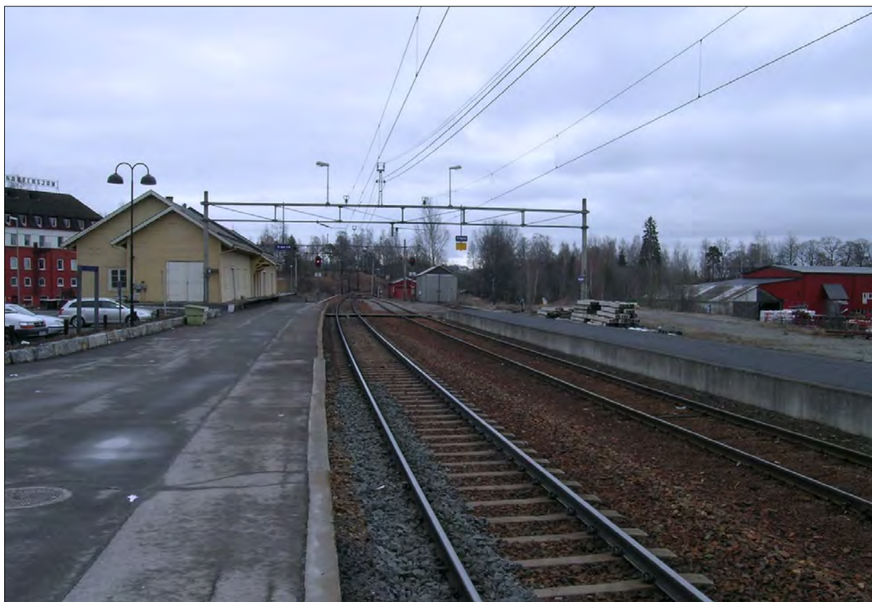
Bilde 4: Bildet viser nåværende Brumunddal stasjon, sett mot sørøst. Avstanden til Brumunddal sentrum (utenfor venstre bildekant) er ca. 500 meter. Foto: © Norsk Bane AS.
