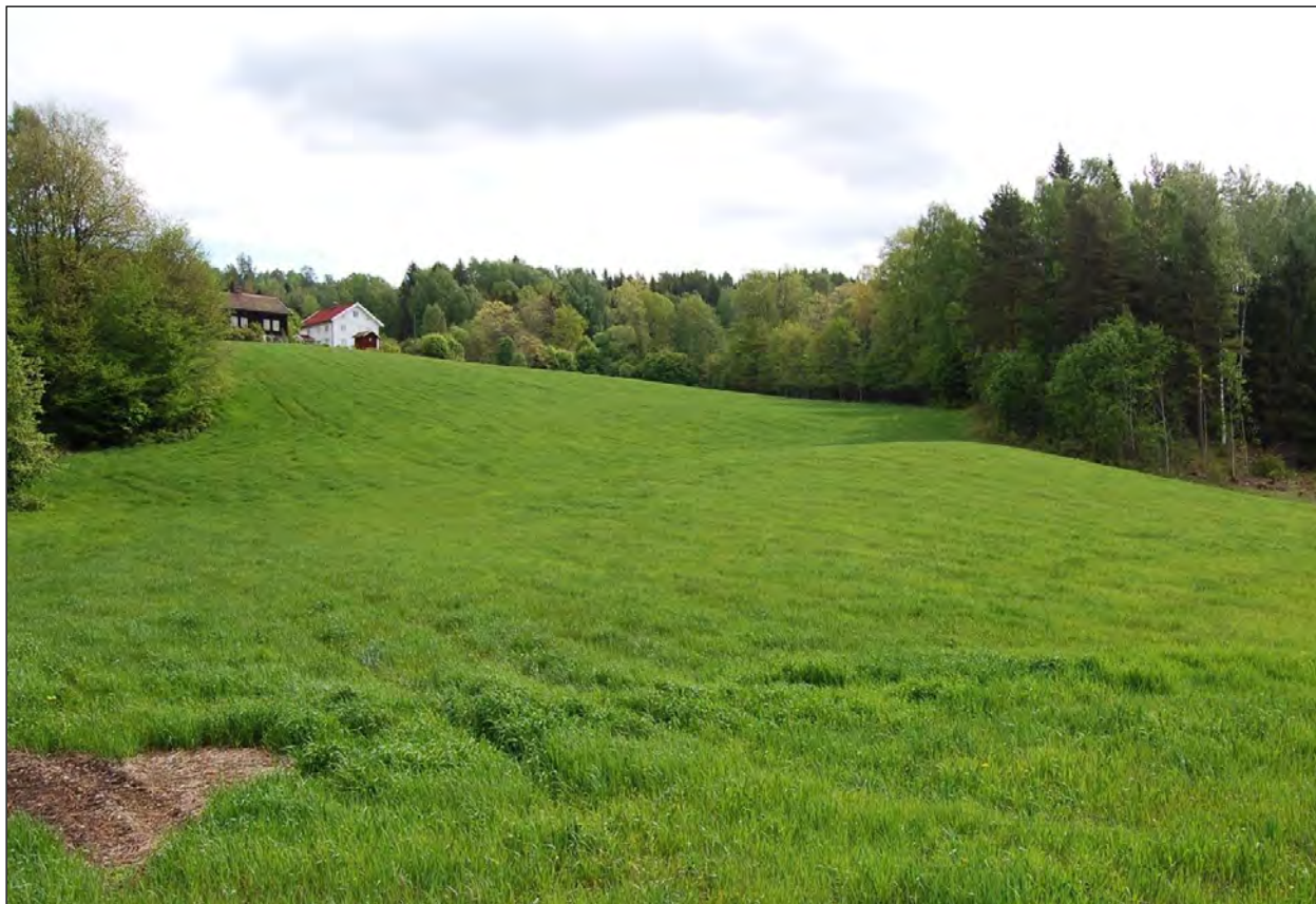
Bilde 24: Mellom Hundskjøl og Bergseng vil banen for det meste gå gjennom barskog. Et av de få unntakene er en ca. 100 meter lang strekning tvers over enga nedenfor gården Moen, midt på bildet. Foto: © Norsk Bane AS.
