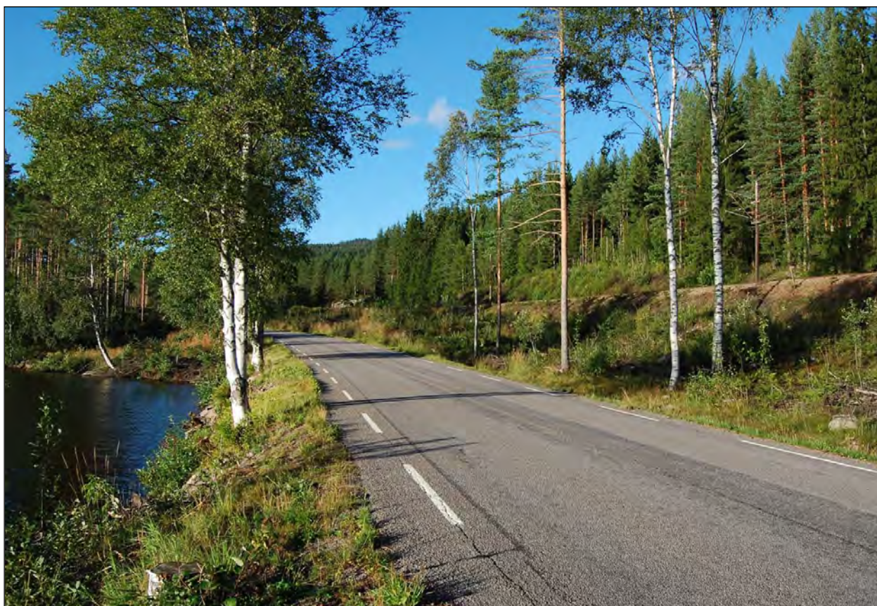
Bilde 10: Nord for Svartberget vil togpassasjerene kunne få flott utsikt over Harestuvatnet. Fram til Harestua stasjon er store deler av banen er planlagt på en ca. 5 meter høy fylling. Bildet er tatt litt sør for Monsrudvika, og banen er planlagt ca. 15 meter høyere og omtrent 200 meter øst for eksisterende bane. Foto: © Norsk Bane AS.
