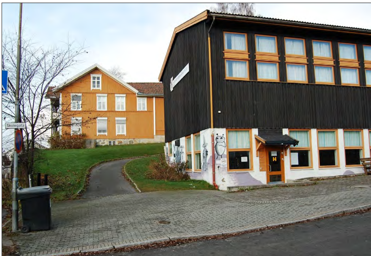
Bilde 20: En linjeføring gjennom den nordvestre delen av Gran sentrum vil gjøre det nødvendig å rive syv bolighus og Gran videregående skole, se bildet. Bygningen i bakgrunnen vil ligge kloss inntil banen. Foto: © Norsk Bane AS.
