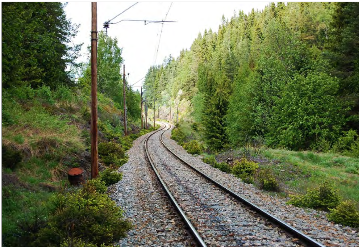
Bilde 26: Like nord for Klyfta vil høyhastighetsbanen gå i eksisterende trasé, på samme høydenivå. Her er det første punktet nord for Gran stasjon der eksisterende og framtidig bane vil møtes, 344 moh. Foto: © Norsk Bane AS.
