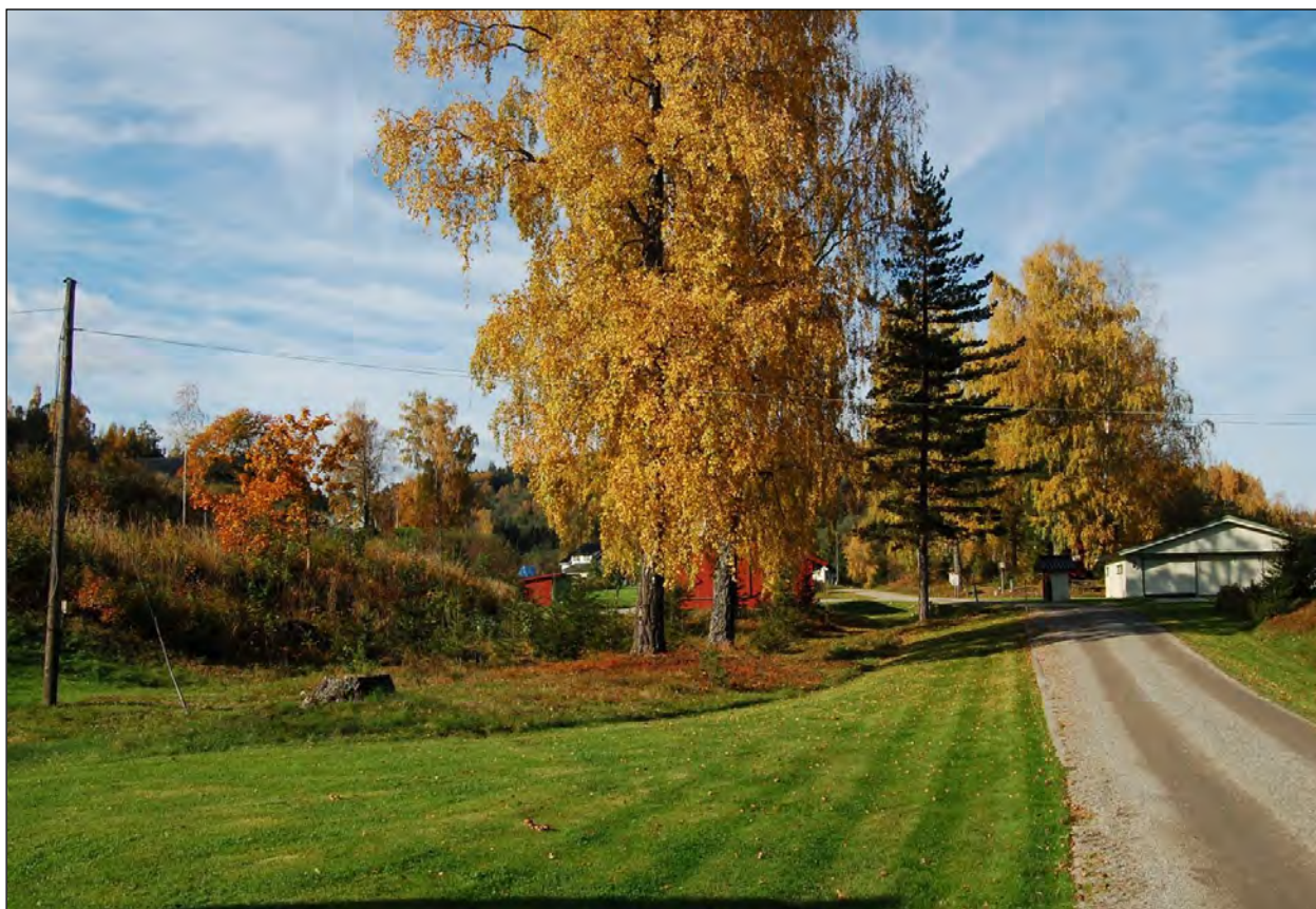
Bilde 44: Ved nordenden av den 1690 meter lange tunnelen mellom Lier og Smedmoen vil overdekningen ikke være tilstrekkelig for en fjelltunnel. Høyhastighetsbanen er planlagt i kulvert, rett under plenen i framgrunnen. Det vil gjøre det nødvendig å rive løa som ligger like bak stedet der bildet ble tatt. En vil også måtte innløse et bolighus på Skulhusodden, ca. 500 meter lenger nordøst. Foto: © Norsk Bane AS.
