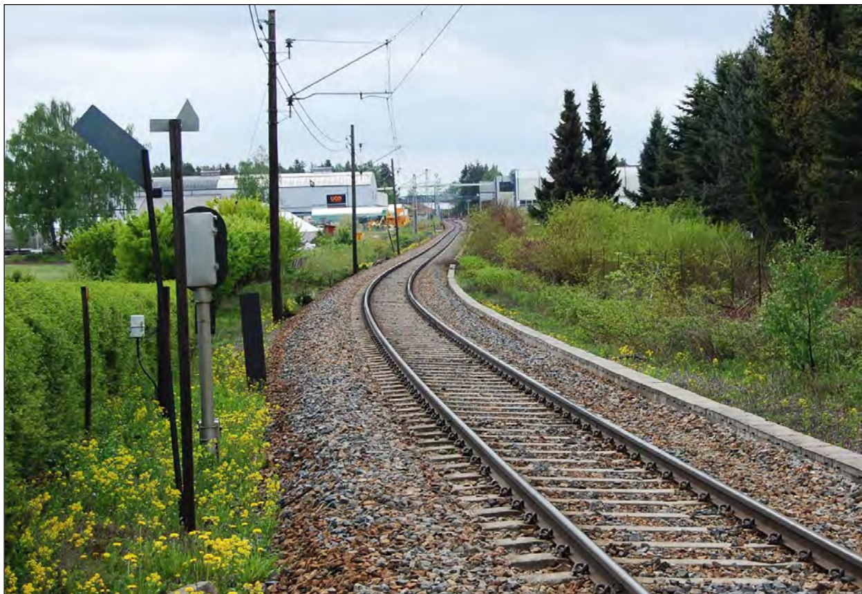
Bilde 46: Nord for de to største produksjonshallene til Moelv Industrier ligger de anbefalte banene vest for eksisterende trasé (til høyre på bildet). Den planlagde tunnelen for tog mot Gjøvik stasjon begynner ved grantrærne i høyre bildekant og går rett under stedet der bildet ble tatt. Foto: © Norsk Bane AS.
