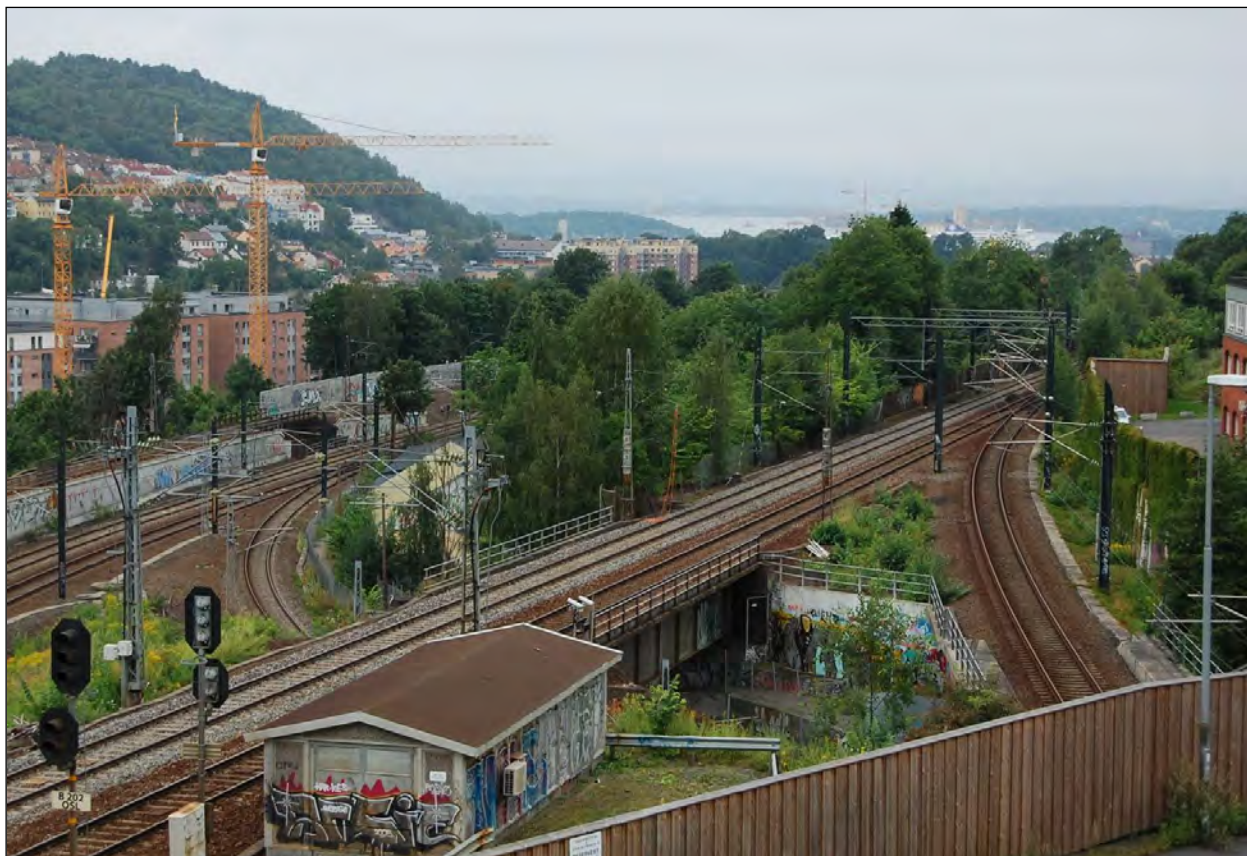
Bilde 4: Parti fra Etterstad. Den dobbeltsporete Hovedbanen sees midt på bildet, like bak bygningen i framgrunnen. Hovedbanen går på bro over Gjøvikbanen (enkeltspor) som kommer inn på den dobbeltsporete Gardermobanen. Til venstre for Gardermobanen (ved de grå veggene) går godsspor til / fra Alnabru. Det går også et spor fra Romeriksporten og inn på Hovedbanen, lengst til høyre. Foto: © Norsk Bane AS.
