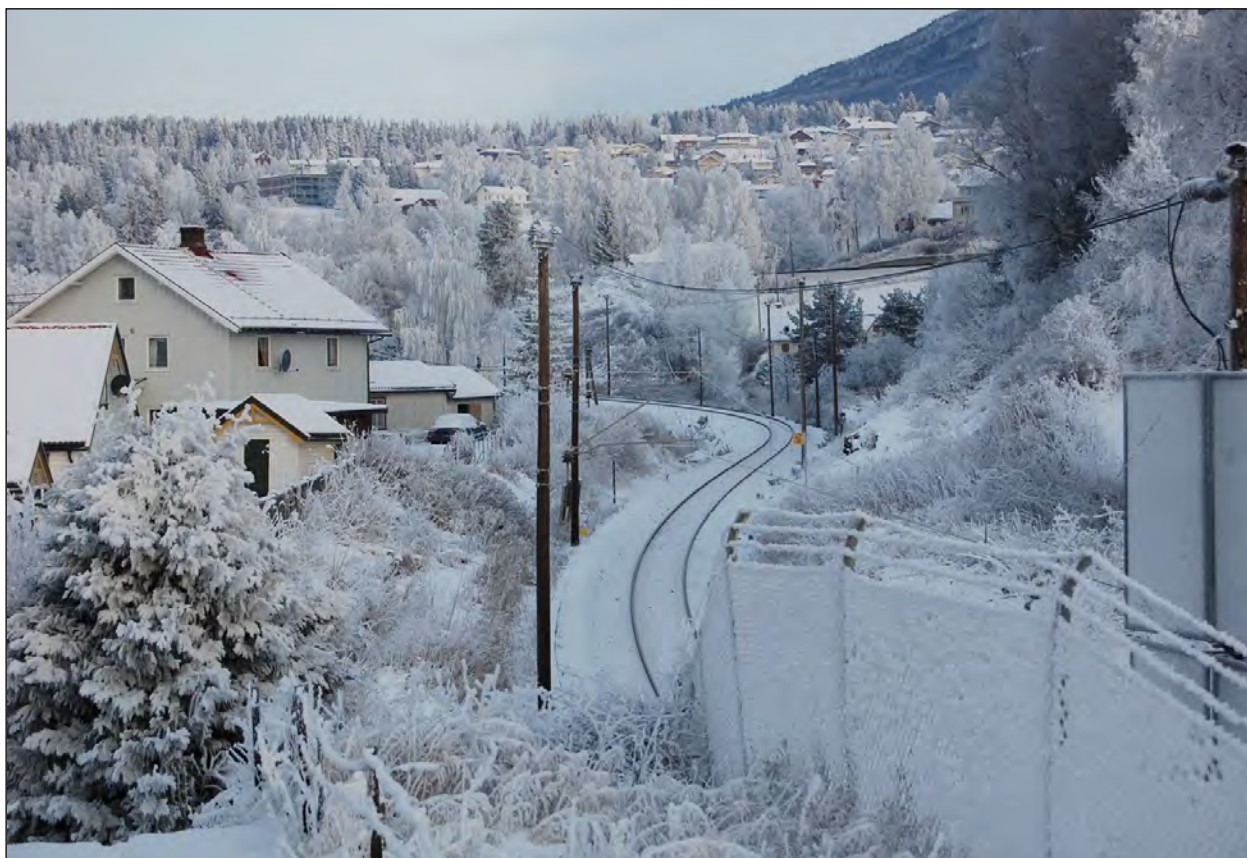
Bilde 3: Til tross for lite ønskelige inngrep i lokalmiljøene, foreslås det noen steder en trasé i dagen for å unngå tunnel i alunskifer. Nord for Gran sentrum, se bildet, kommer planlagt bane ut av skråningen til høyre og krysser over venstresvingen til eksisterende spor (to ganger). På innsiden av denne venstresvingen vil tre bolighus (ikke synlig på bildet) måtte rives. Foto: © Norsk Bane AS.
