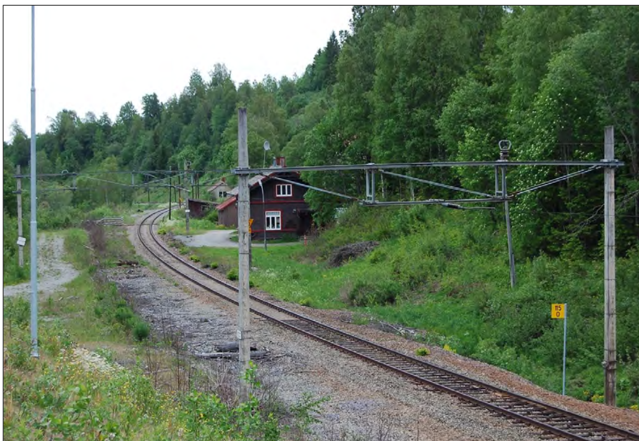
Bilde 37: Ved tidligere Breiskallen stasjon vil høyhastighetsbanen gå under eksisterende trasé, omtrent ved skiltet som viser banedistansen fra Oslo S. Regnet etter ny bane, vil distansen bli 8,5 km kortere. Foto: © Norsk Bane AS.
