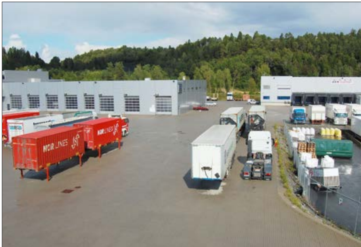
Bilde 33: Den anbefalt traséen i Heistaddalen går midt mellom de to næringsbyggene på bildet og fortsetter mot sør gjennom det inngjerdete området i høyre bildekant, omtrent på bakkennivå. Mellom de to byggene er det planlagt en undergang under sporene, med tilkomst fra tre retninger: fra framkanten av bygget til venstre, fra bakkanten av bygget til venstre og fra framkanten av bygget til høyre. Bak næringsbygget til venstre skimtes deler av jordbruksområdet som høyhastighetsbanen vil måtte krysse like sør for tunnelen under Skavråkåsen. Foto: © Norsk Bane AS.
