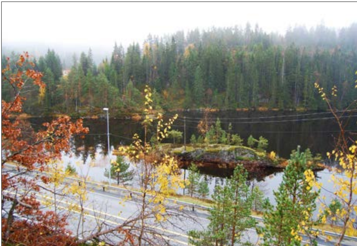
Bilde 53: På fyllingen i Bråtvannet (litt til venstre for holmen) når traséen mellom Tangen og Brokelandsheia sitt høyeste punkt, 122 moh. Derfra og fram til Skorstøl går 69 % av strekningen på bro eller i tunnel. Foto: © Norsk Bane AS.
