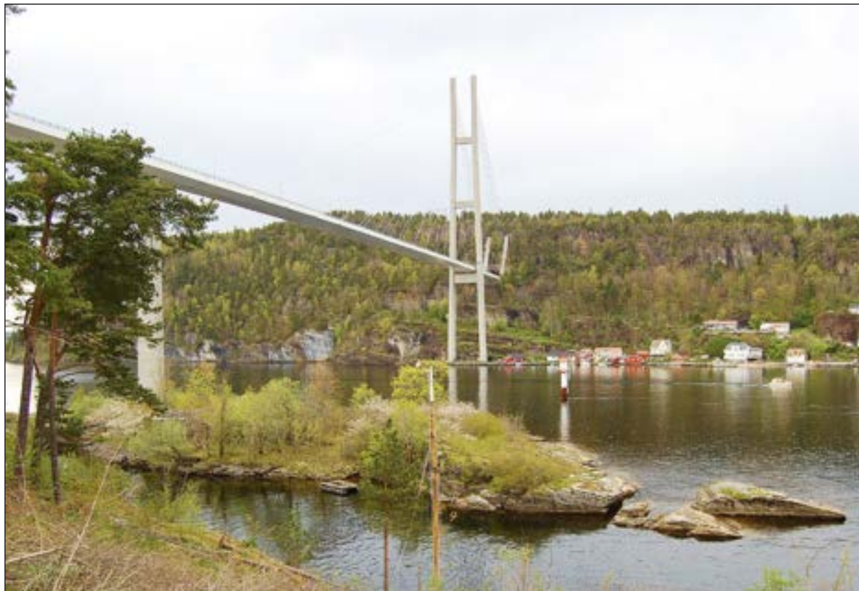
Bilde 27: For kryssingen av Frierfjorden finnes det neppe noe annet traséalternativ enn rett ved siden av Grenlandsbrua. Lenger øst (til høyre) vil jernbanen komme i konflikt med bebyggelse, lenger vest (til venstre) med et naturreservat. Grenlandsbrua har et hovedspenn på 305 meter og en fri seilingshøyde på 50 meter. Foto: © Norsk Bane AS.
