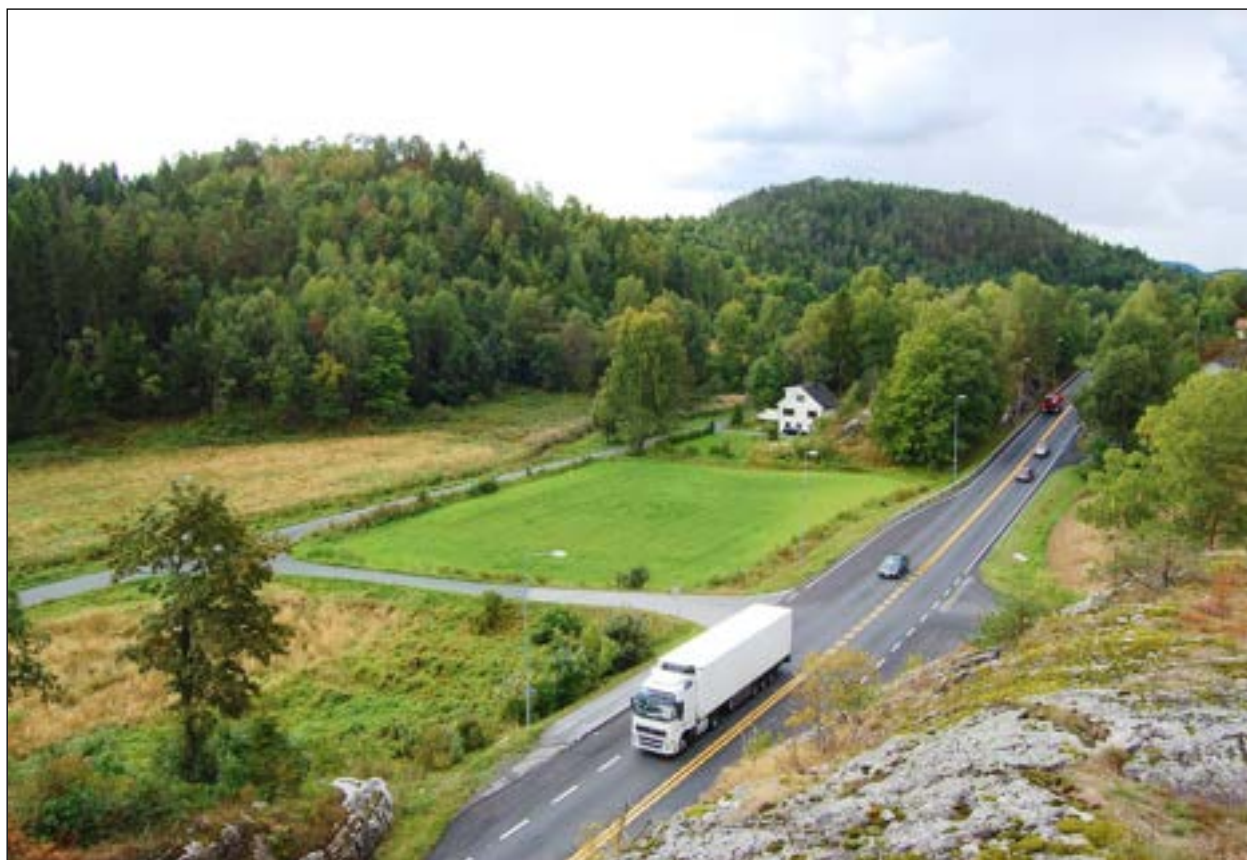
Bilde 28: Mellom Stathelle og Feset går eksisterende europavei 18 flere steder langs kanten av et smalt belte med jordbruksareal, som her ved Vissestad. Der vil en ofte ha mulighet til å bygge høyhastighetsbanen på motsatt side av jordbruksbeltet, på fjellgrunn og gjennom skogsterreng, ca. 150–200 meter fra E18. Foto: © Norsk Bane AS.
