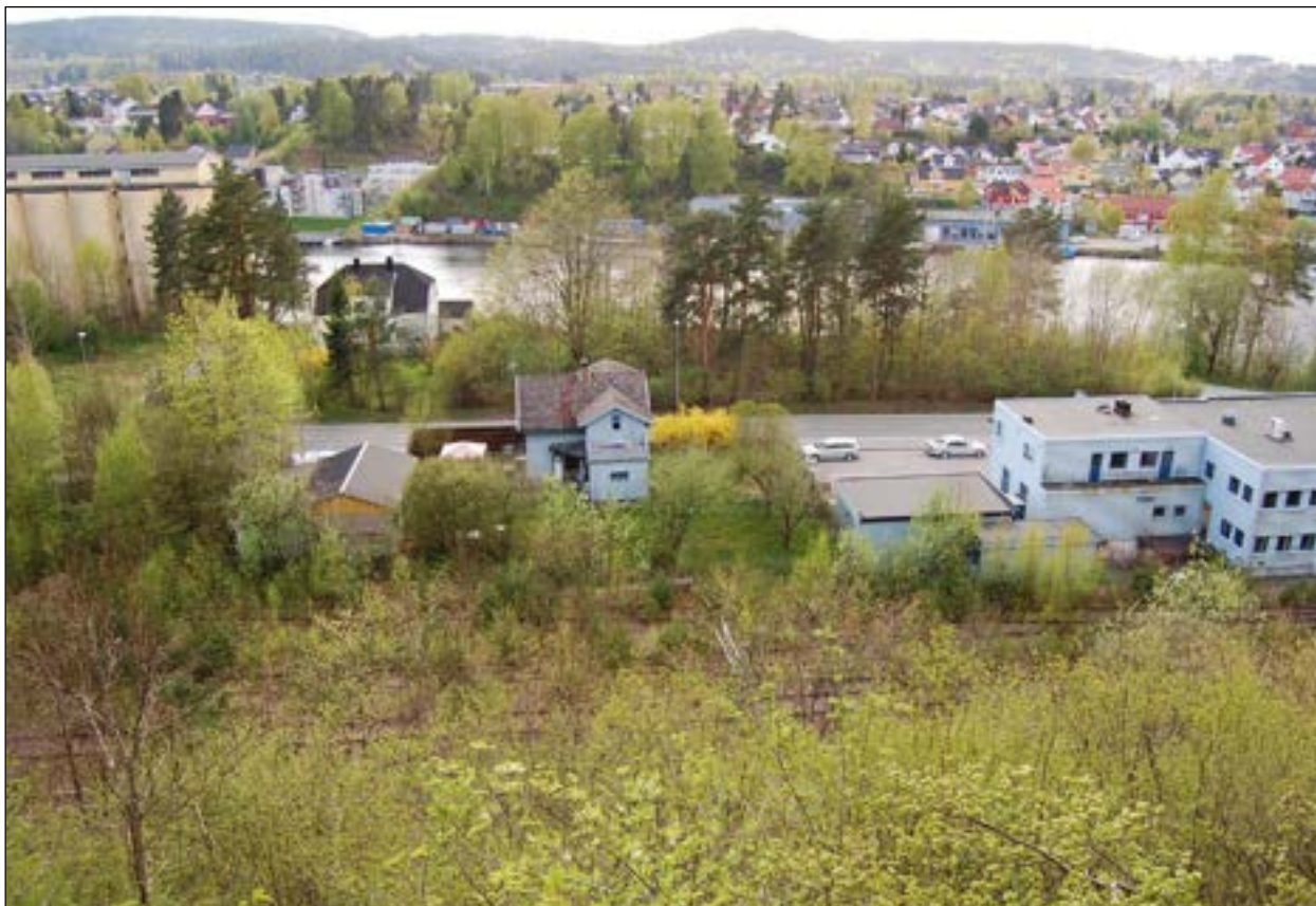
Bilde 24: Noen steder er det lite eller ingen boligbebyggelse nær Bratsbergbanen, som f.eks. ved Uthauen. Her er den nye banen planlagt i dagen, nær fjellfoten (i framkant av bildet.) Bildet er tatt mot vest. Foto: © Norsk Bane AS.
