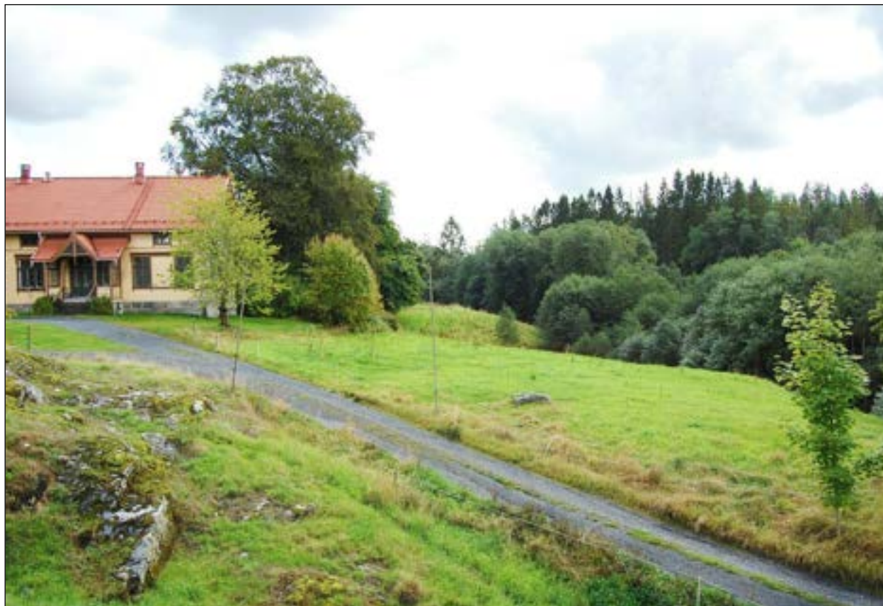
Bilde 35: Høyhastighetsbanen vil på nærmeste ligge 210 meter sørøst for Bamble prestegård (se bildet), godt skjermet av skog. Sør for prestegården vil banen krysse Troll dalen (i bakgrunnen, midt på bildet) på en 250 m lang bro med 35 meters høyde over bekken (fra km 62,9). De midtre delene av broen vil være synlig fra Bamble kirke og fra prestegården. Tillat toghastighet på broen vil være 280 km/t. Foto: © Norsk Bane AS.
