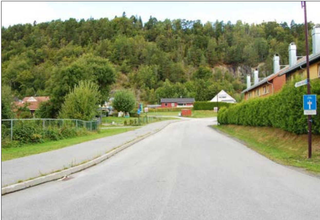
Bilde 26: Ved Liane barnehage (den nærmeste bygningen bak trærne til venstre) vil det ligge fire spor i kulvert under bakken. Bildet er tatt mot nord, noen få meter over taket av den planlagte betongtunnelen for det østligste av de fire sporene. Dette sporet er ment for tog som kommer fra Sørlandet via en bro over Frierfjorden ved Brevik og skal til Vestfold via Porsgrunn stasjon. Det røde huset i bakgrunnen vil måtte innløses. Tillatt hastighet på de to midtre sporene (for gjennomgående tog fra Sørlandet til Skien og Oslo/Vestlandet og omvendt) vil være 240 km/t, økende til 260 km/t sør for tidligere Vallermyrene Leir. Foto: © Norsk Bane AS.
