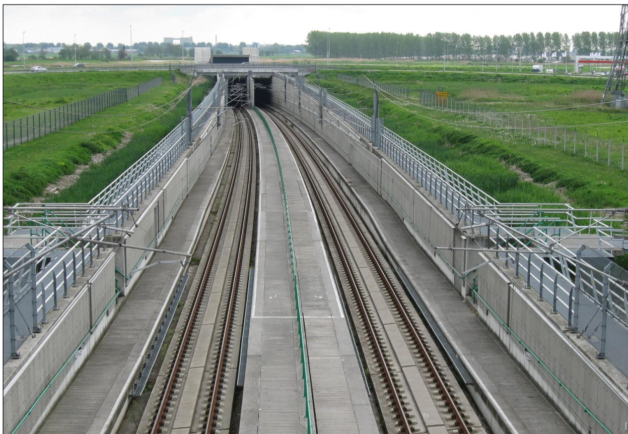
Bilete 3-6: Den 8,7 km lange Groene Hart-tunnelen er ein del av høgfallsbanen «HSL Zuid» i Nederland. Tunnelen blei bygd med én stor tunnelboremaskin, men har i heile si lengd ein skiljevegg i betong mellom dei to spora. Sporavstanden er noko større enn normalt, men vesentleg mindre enn ved to parallelle, einspora tunnelar. Biletet er teke ved den sørlege portalen av tunnelen, nær Zoetermeer. Foto: © Daniel Sparing, flickr.com , lisens: creative commons .
