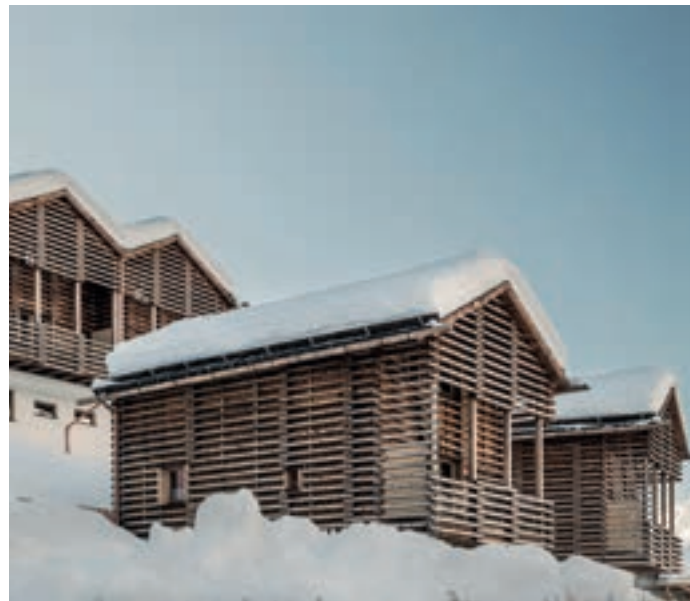
Fritidshus i See im Paznauntal, Österrike. Det yttre fasadskiktet består av brända granstammar som klyfts i fjärdedelar och därefter "flätats" samman.
