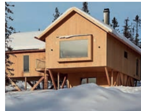
Fritidshus i Vemdalen, ritat av Wingårdh Arkitekter. Variant på uppstolpad plintgrund med snedstärvor med plats för parkering.
