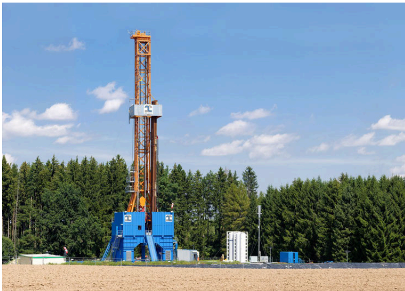
Geothermie-Bohranlage in Bayern (Bild: © Richard Bartz, CC BY-SA 2.5)
