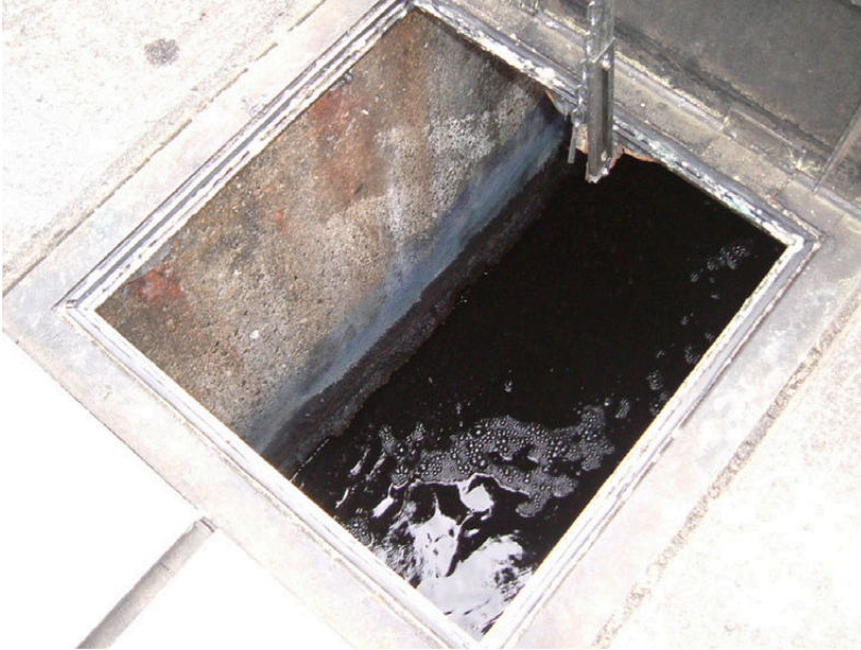
Abwasserschacht (Bild: C. Bagutti, Kantonels Laboratorium Basel-Stadt)
