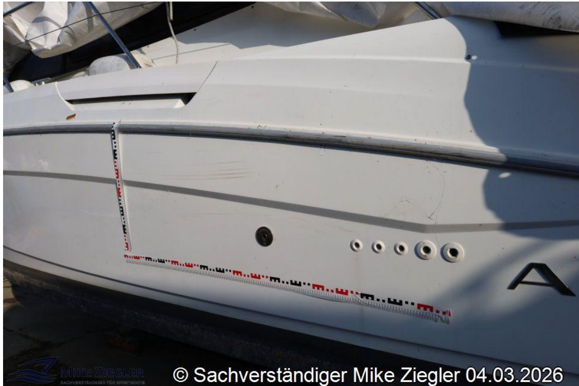
Foto 5: Gesamtansicht Schaden Backbord Höhe Bordauslässe
