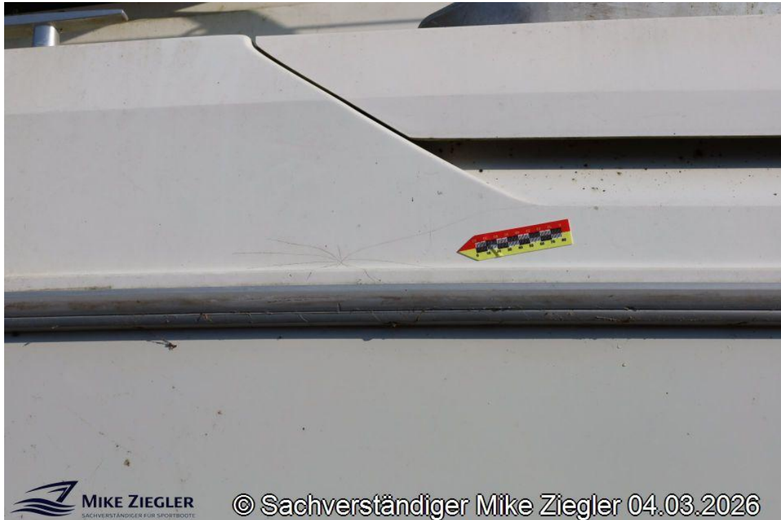
Foto 7: Detailansicht Altschaden Glasbruch Höhe Scheuerleiste Mitte Backbordseite
