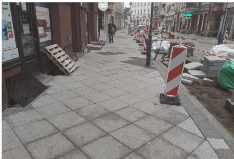
Fot. wymiana płyt chodnikowych, Kalisz, Arkadiusz Pacholski
