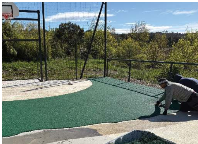
Application de la finition PCE : gâchée colorée au premier plan, tirée à la lisseuse par les poseurs.
