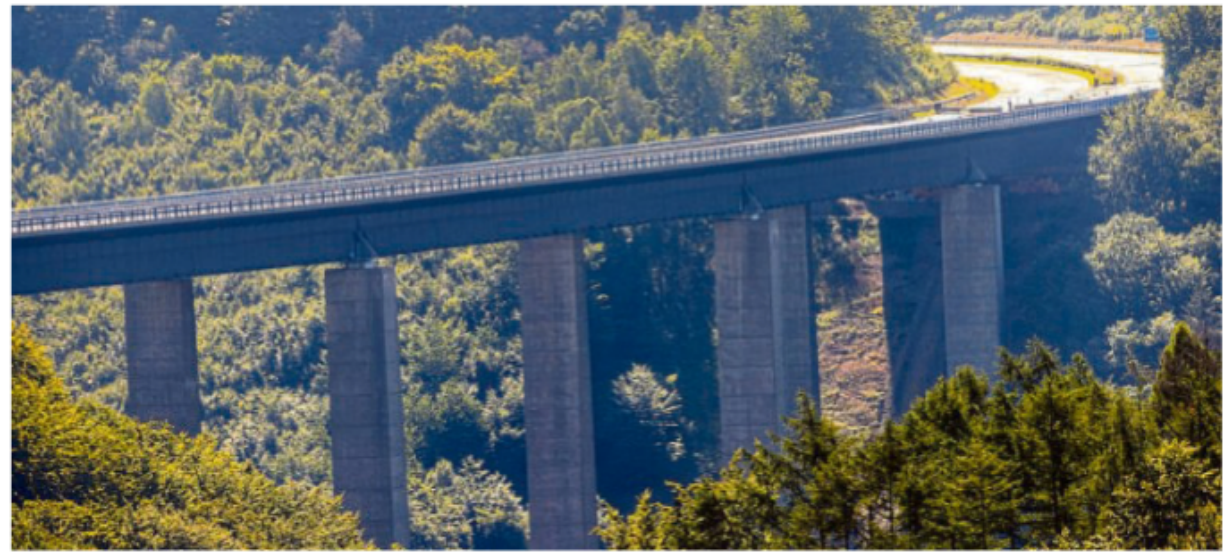
Idyllisch liegt sie da, die Rahmedetalbrücke in den Hügeln des Sauerlands bei Lüdenscheid. Eigentlich sollte sie noch in diesem Jahr gesprengt werden. Doch nicht einmal das klappt.
