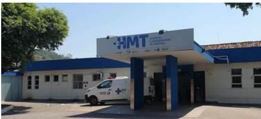
Figura 42: Hospital e Maternidade de Timóteo
