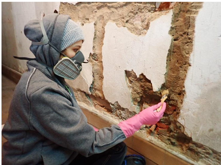
Fot.4. Zabezpieczenie tynku (fot. J. Krasowska)
