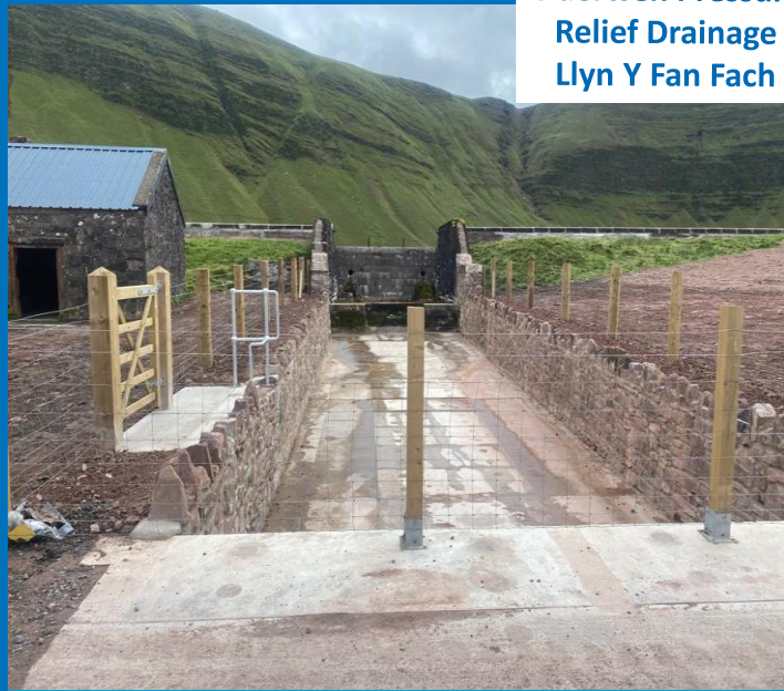
Llyn Y Fan Fach - New spillway
