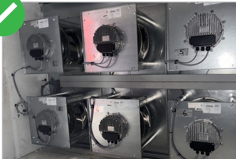
ECFanGrid est une solution de modernisation efficace pour remplacer, par exemple, les anciens ventilateurs à courroie. La trousse de modernisation ECFanGrid comprend toutes les pièces mécaniques : ventilateurs, armoire, grille et vis.
