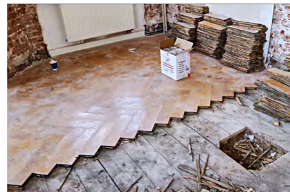
Rückbau des historischen Blind- und Parkettbodens und Wiedereinbau des Blindbodens, der Brandschutzplatten und des wiederhergestellten Originalparketts
