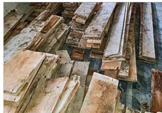
Rückbau des historischen Blind- und Parkettbodens und Wiedereinbau des Blindbodens, der Brandschutzplatten und des wiederhergestellten Originalparketts
