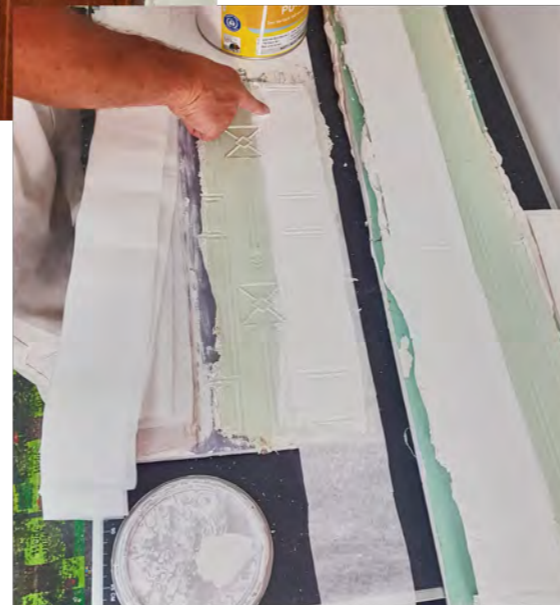
Herstellung der neuen Form der Prägetapete
