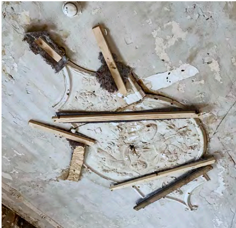
Notsicherung zur Stucksicherung
