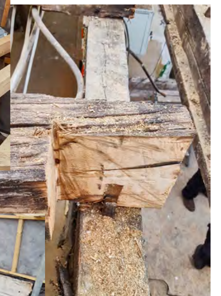
Anschluß für neuen Balkenkopf
