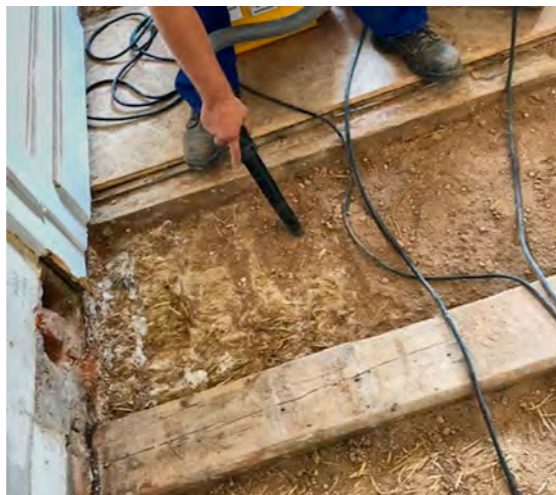
Absaugung der Schüttung zur Trocknung der Lehmwickel
