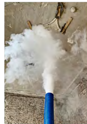
Fogging zur Schimmelbekämpfung
