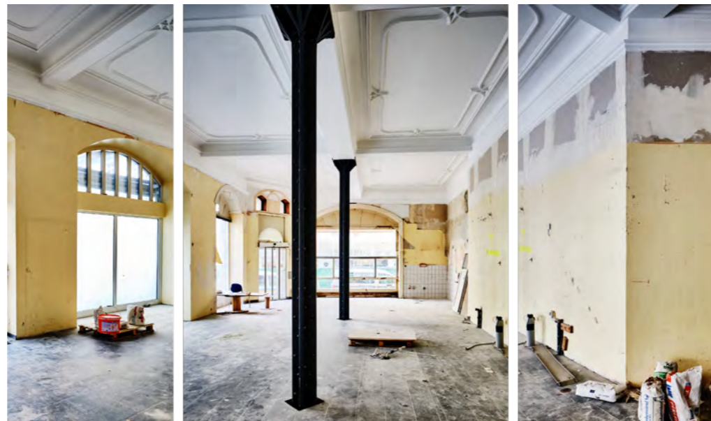
Die Decke im Erdgeschoß nach der Renovierung
