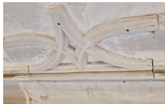
Nachgeformtes Stuckelement
