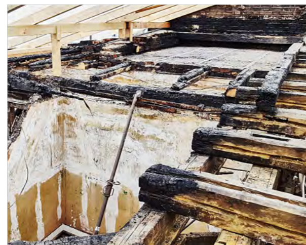
Balkenlage über DG
