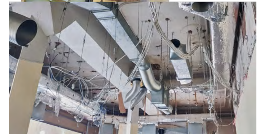
Befestigung der Lüftung in der Stuckdecke
