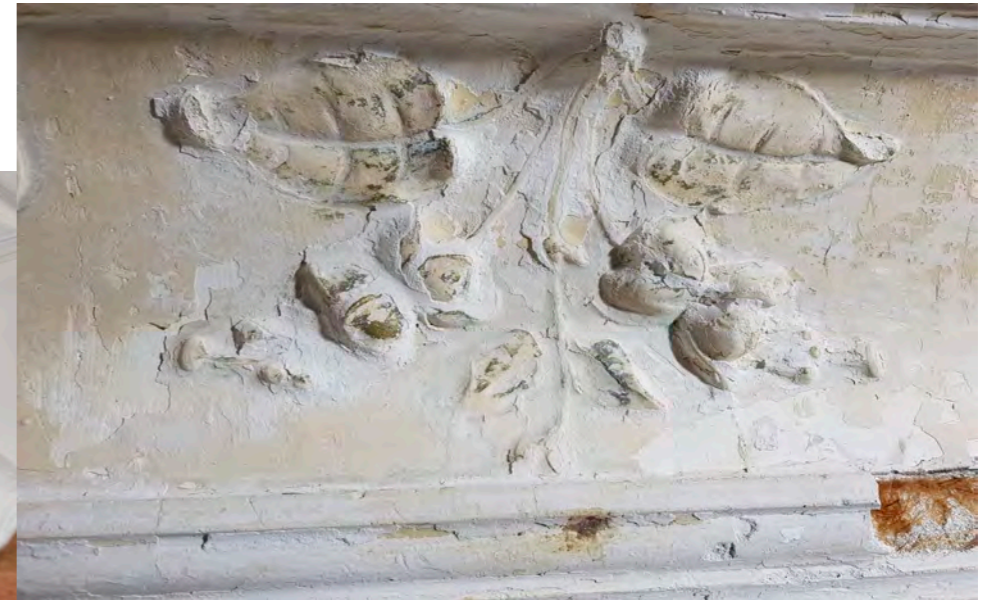
Ergebnis nach der Knochenleimbehandlung vor der Reinigung und Restaurierung
