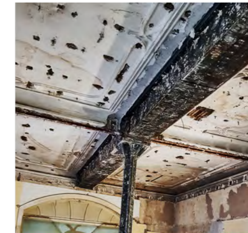
Die Decke nach dem Rückbau der Lüftung
