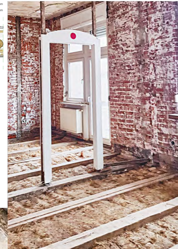
Beim Rückbau blieb nur die Türe erhalten
