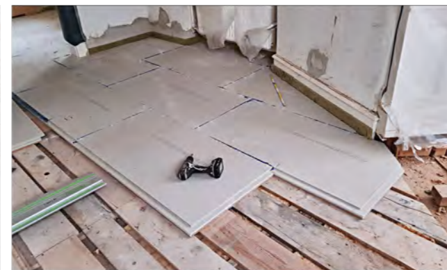
Rückbau des historischen Blind- und Parkettbodens und Wiedereinbau des Blindbodens, der Brandschutzplatten und des wiederhergestellten Originalparketts
