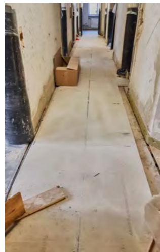
Einbau von Brandschutzplatten
