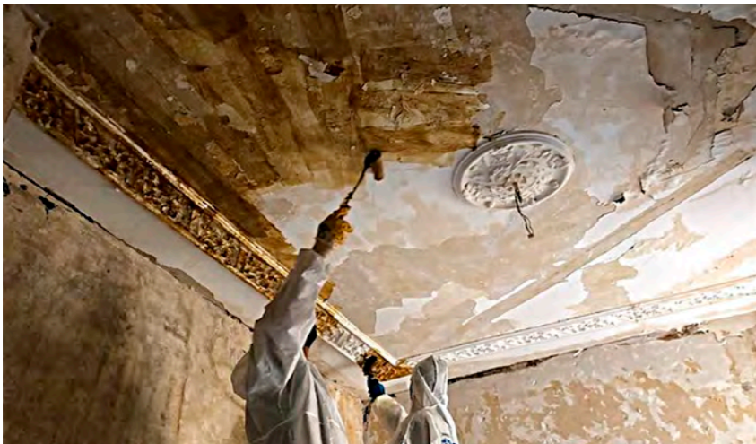
Mit Knochenleim wurden die alten Farbschichten entfernt
