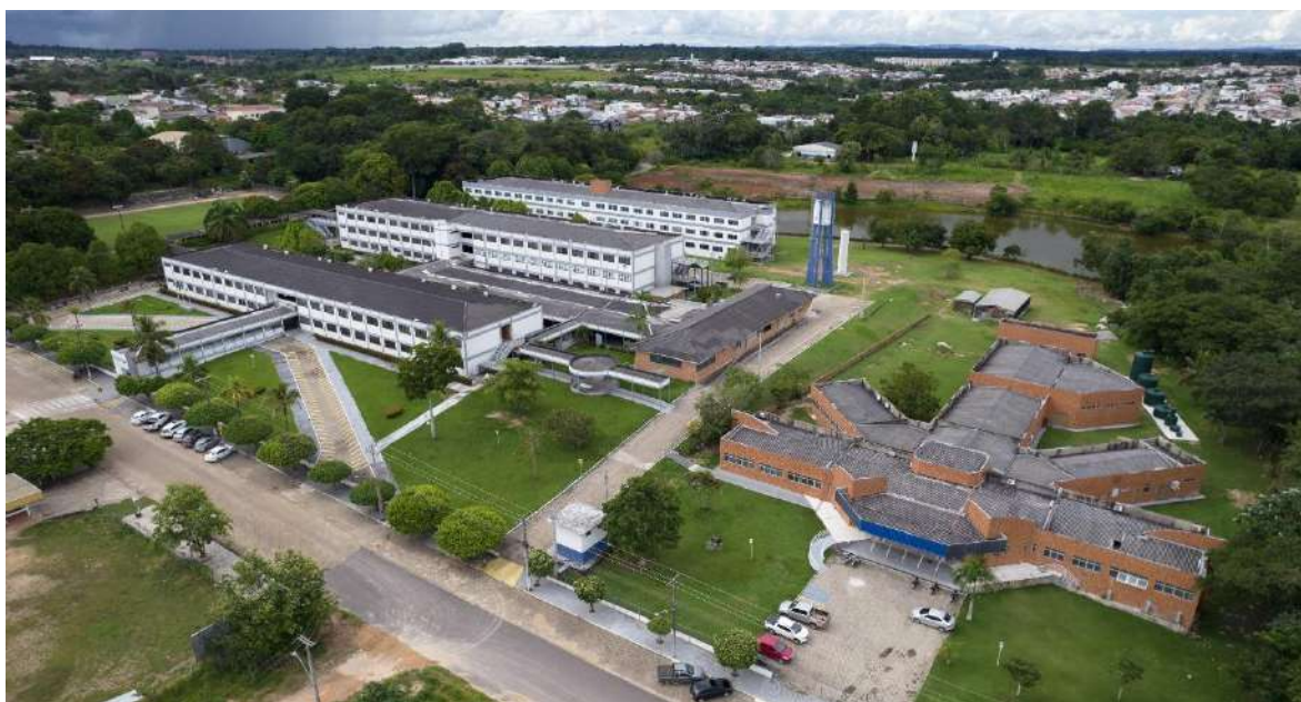
Primeiro plano, Clínica Veterinária . Ao centro, depósito e a esquerda, prédios A, área de convivência, prédio B e V. Ao fundo, lado e área verde.
