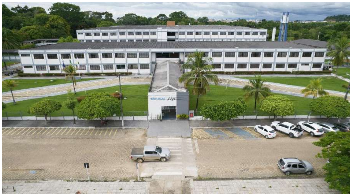
Primeiro plano, estacionamento externo, corredor de entrada para pedestres , a direita e esquerda em primeiro plano, estacionamentos para moto, de uso de alunos
