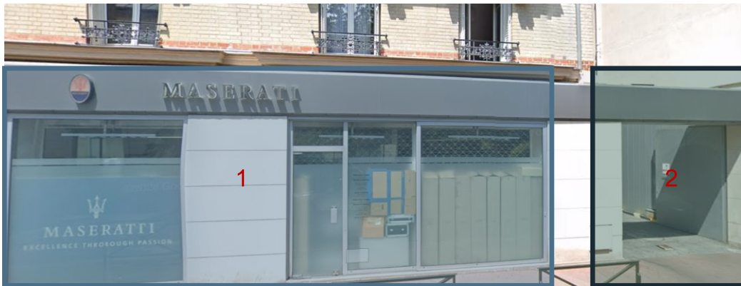
Aperçu de la façade:
