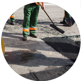
Travaux publics (plateformes, remblais, fondations routières)
