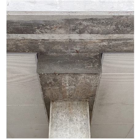
Betonstütze und Untersicht Decke Parking
