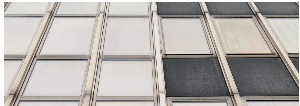
Spiegelfoliertes Fensterglas. Bleibt im Treppenhaus erhalten
