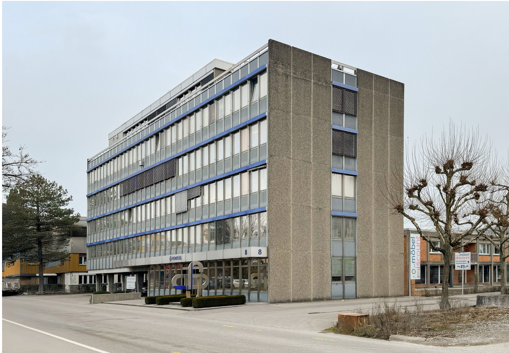
Fotoaufnahme 08.12.2025. Derzeitige Situation - Industriering 8a, 3250 Lyss
