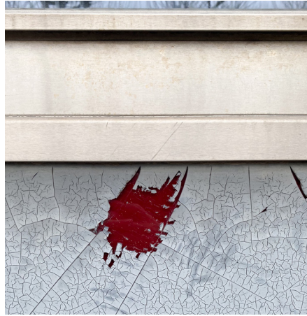
Bestehende Fassade - Folierung NCS S 4010-R90B
