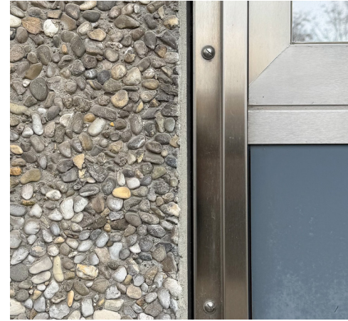
Waschbeton bleibt ein Bestandteil der Fassade
