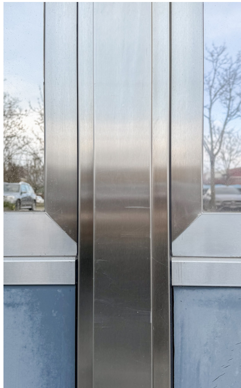
Fensterrahmen und vertikale Profile
