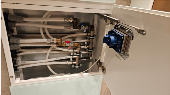
Kontroll av rørskap.
