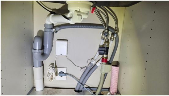
Kontroll av røropplegg.
