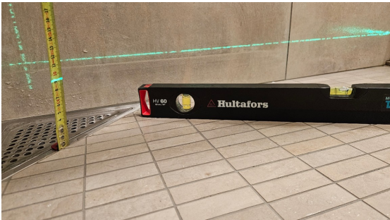
Kontroll av fall mot sluk.
