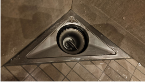
Kontroll av sluk.
