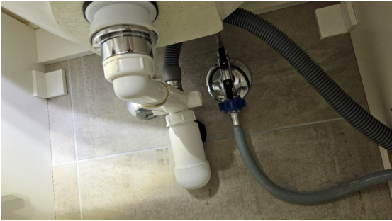
Kontroll av røropplegg.
