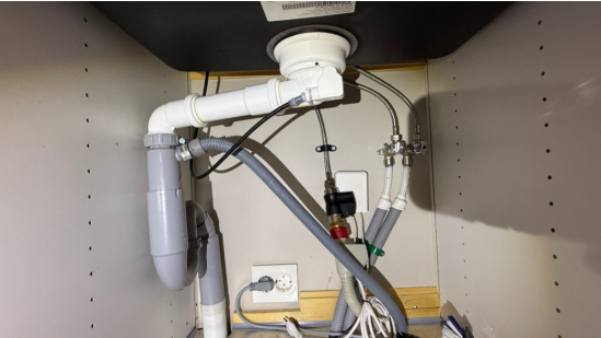
Kontroll av røropplegg.
