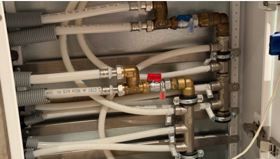
Kontroll av rørskap.
