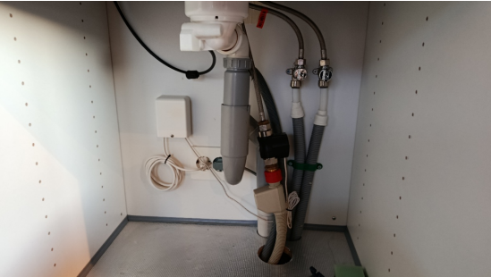
Kontroll av røropplegg.
