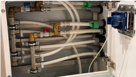
Kontroll av rørskap.
