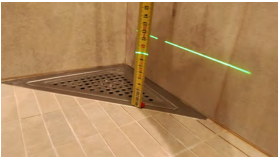
Kontroll av fall mot sluk.
