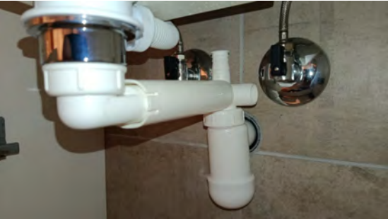
Kontroll av røropplegg.
