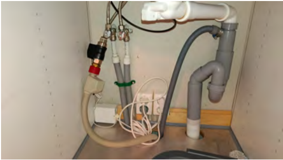
Kontroll av røropplegg.
