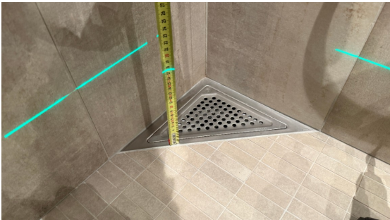
Kontroll av fall mot sluk.
