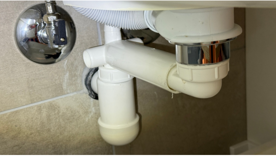
Kontroll av røropplegg.
