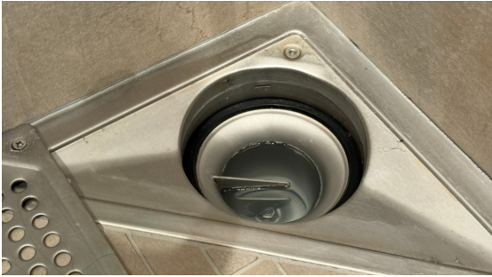
Kontroll av sluk.
