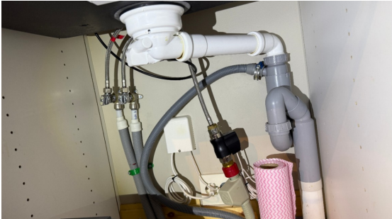
Kontroll av røropplegg.
