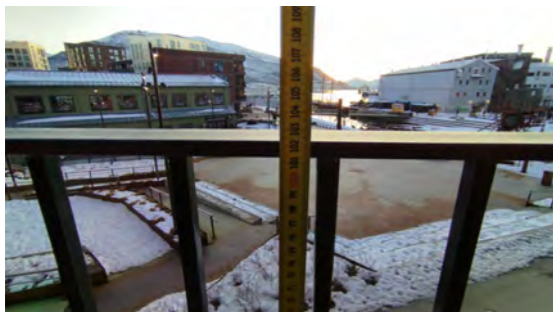
Kontroll av rekkverkshøyde.
