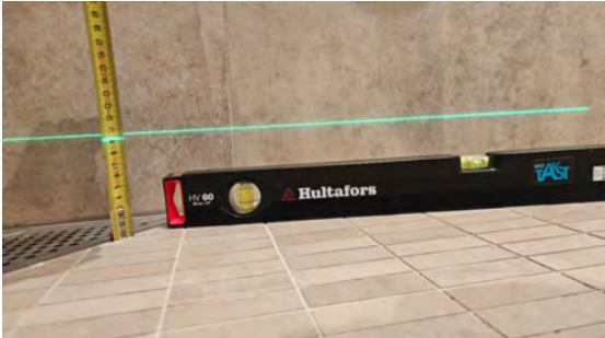
Kontroll av fall mot sluk.
