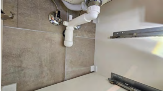
Kontroll av røropplegg.
