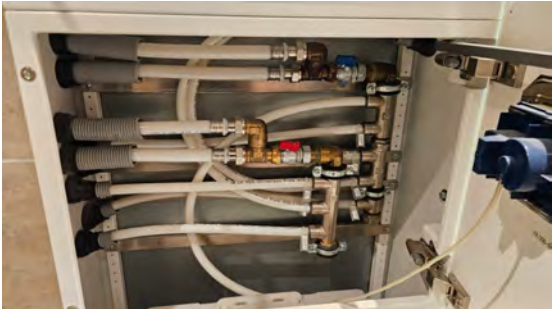
Kontroll av rørskap.
