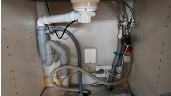
Kontroll av røropplegg.
