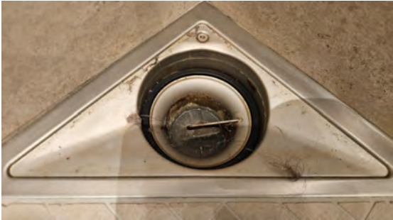
Kontroll av sluk.
