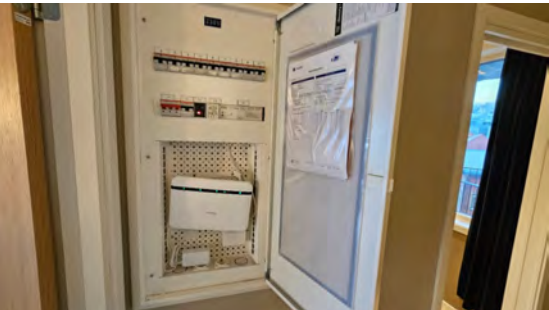
Kontroll av el-skap.
