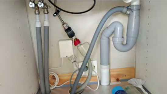
Kontroll av røropplegg.
