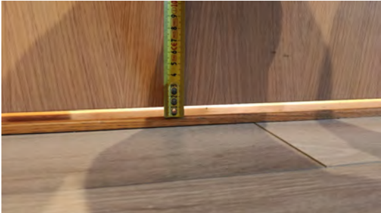
Kontroll av høyde på luftespalte under døren.
