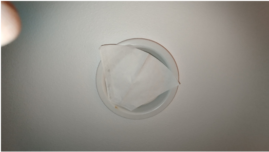
Funksjonstest av avtrekk.
