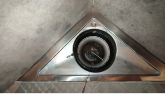
Kontroll av sluk.
