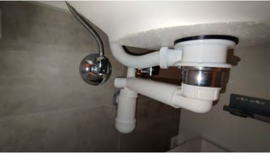
Kontroll av røropplegg.
