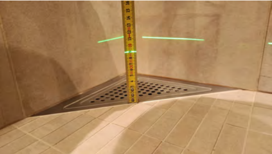
Kontroll av fall mot sluk.
