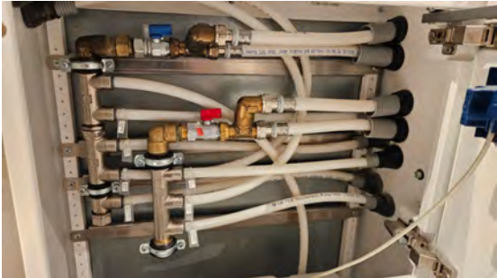
Kontroll av rørskap.
