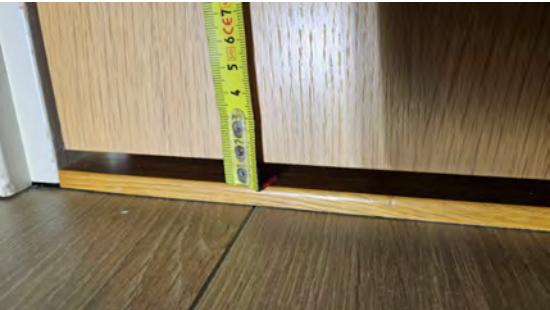
Kontroll av høyde på luftespalte under døren.
