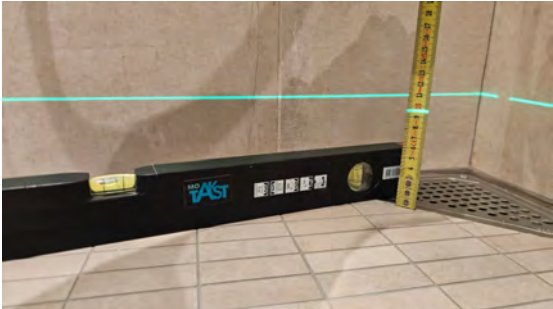
Kontroll av fall mot sluk.
