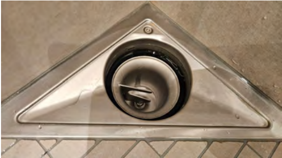
Kontroll av sluk.
