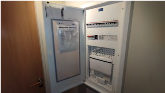
Kontroll av el-skap.
