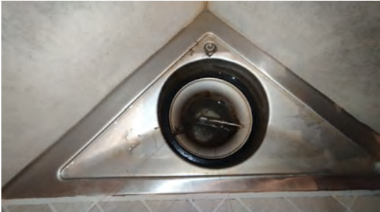
Kontroll av sluk.
