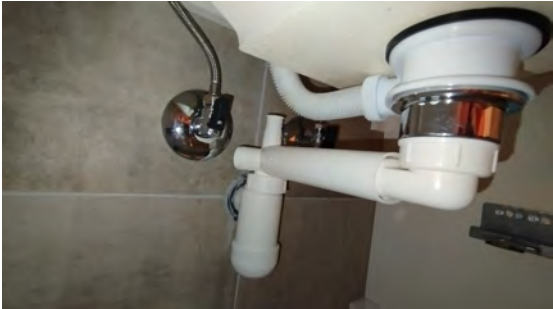
Kontroll av røropplegg.
