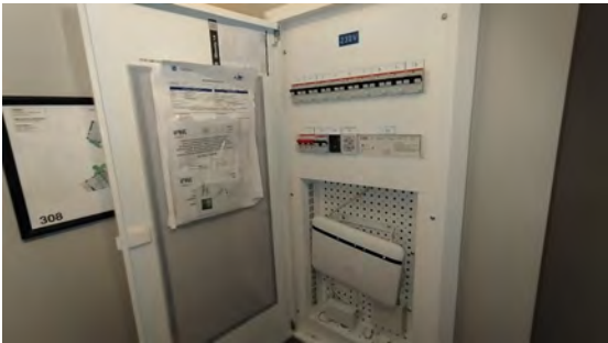
Kontroll av el-skap.
